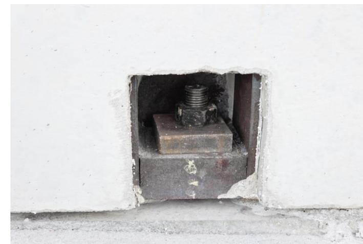
Ligação com sapata metálica
