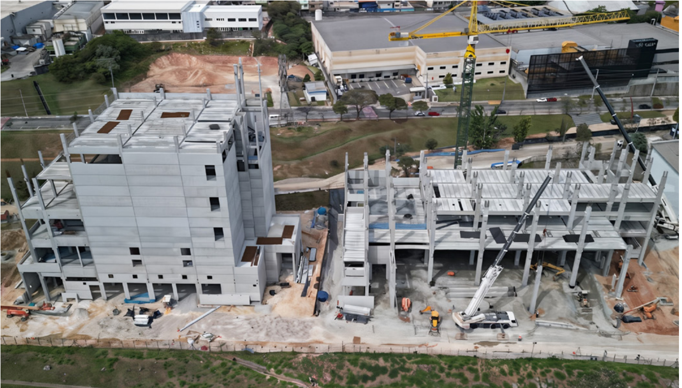
O Scala Data Center – TB08 teve um incremento de cerca de 1.190 peças à estrutura, resultando em 3.919 peças pré-fabricadas para sua construção
