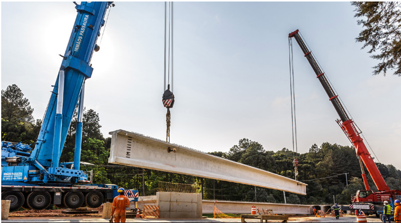
A complexidade da duplicação da PR-092 exigiu o desenvolvimento de um projeto de pós-tensão, acompanhado por um estudo detalhado de viabilidade para o transporte das peças
