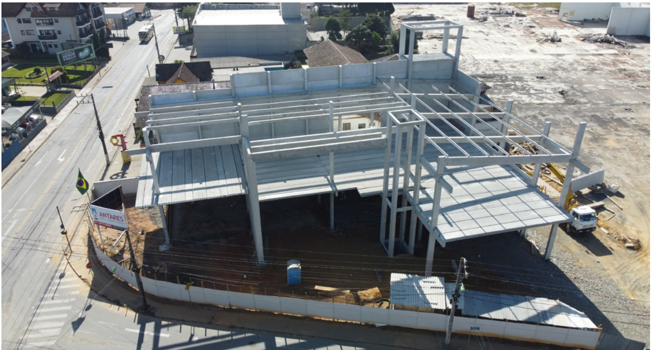
O pré-fabricado de concreto atendeu completamente os requisitos do edifício da Vem Participações, como prazo, os grandes vãos e o design
