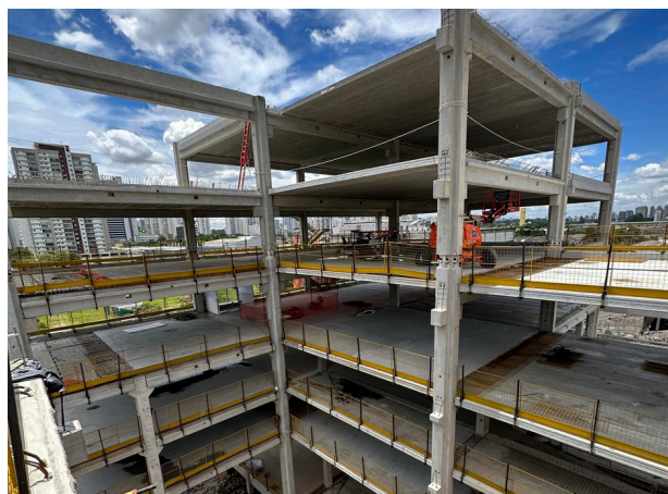
b) Montagem da estrutura – emendas dos pilares em cruz.
