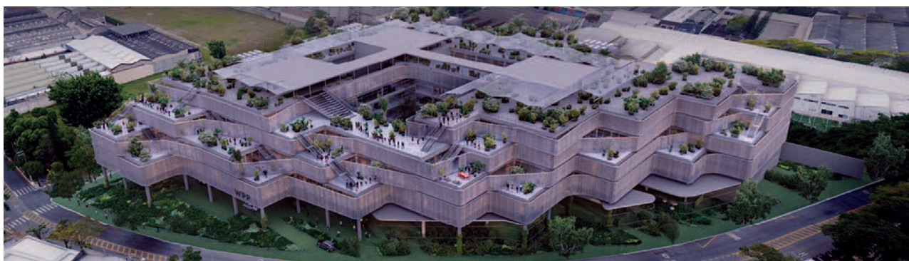
Figura 3: Edifício Campus WPP - Perspectiva de projeto da obra acabada em sistema pré-fabricado (Fonte:www.wpp.com [7]).
