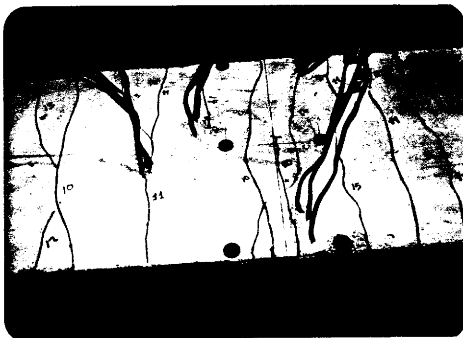
Foto 6.13 - Detalhe da fissuração na mesa tracionada do modelo 1 após o ensaio
