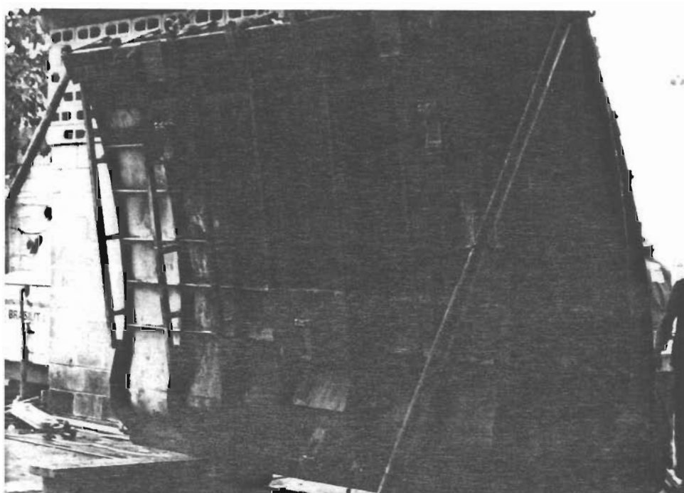
Foto 4.12 – Fôrma de grandes dimensões podendo-se notar três bases para os vibradores.
