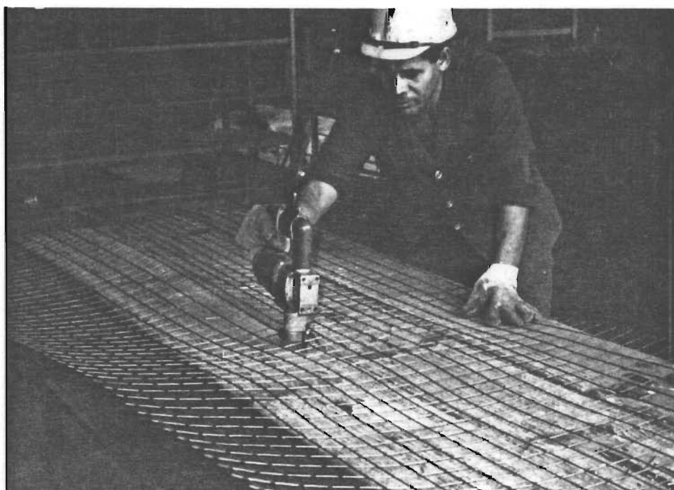
Foto 4.7 – Cortadeira elétrica de telas utilizada no Cedec/Emurb.
