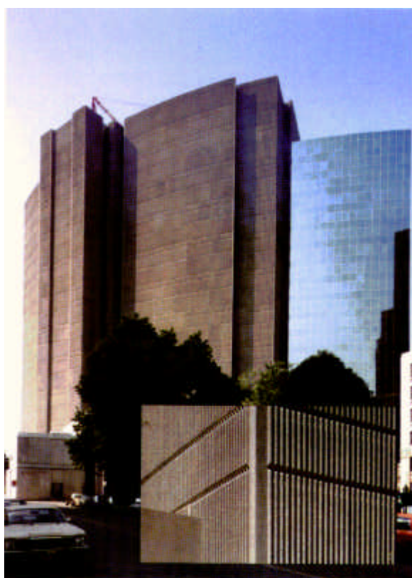
Figura 2.4- Edificações com painéis de concreto pré-moldado [PCI(1989)] (cont.)
