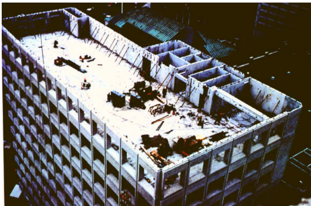
Figura 2.11- Exemplo de edificação com painéis estruturais [PCI(1989)]
