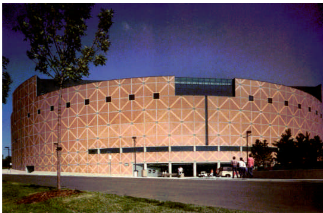
Figura 2.4- Edificações com painéis de concreto pré-moldado [PCI(1989)]
