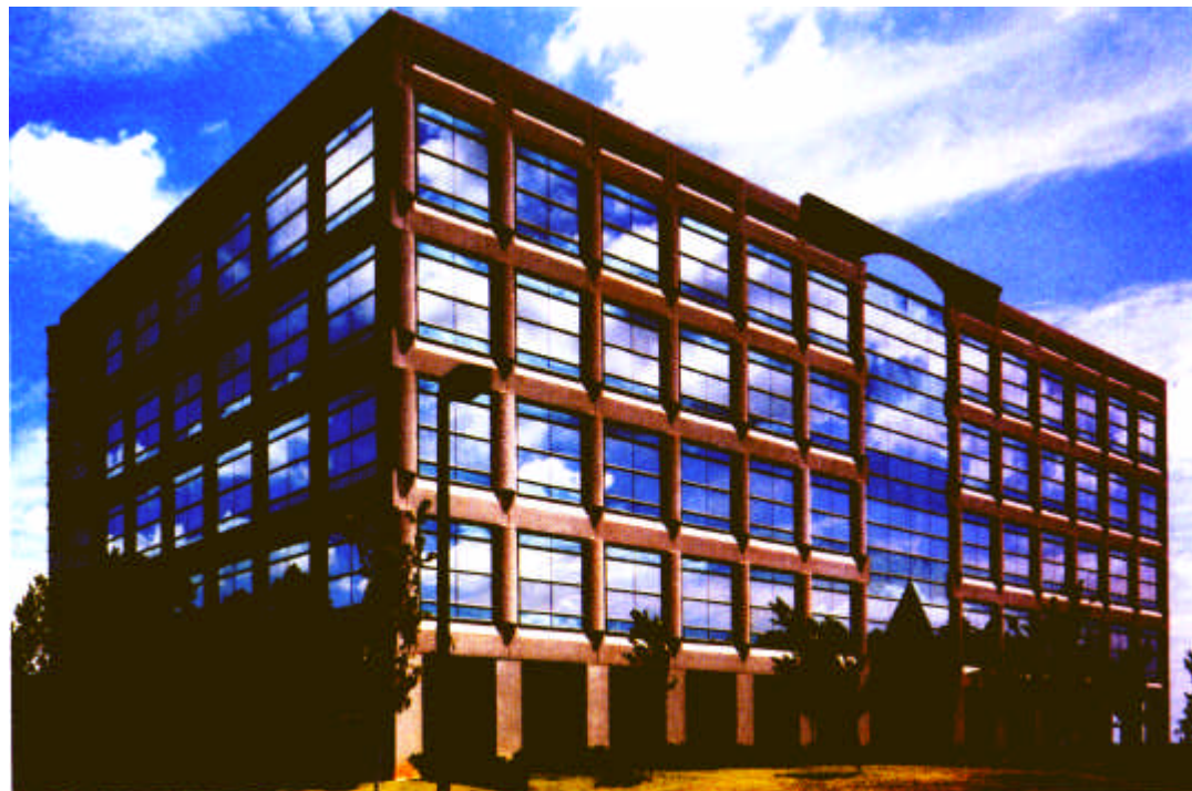
Figura 2.8- Exemplo de edificação com painel do tipo “spandrel” [PCI(1989)]
