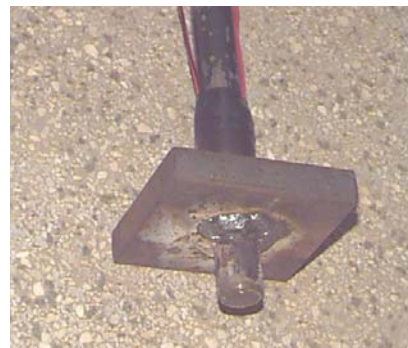
Figura 5.11 - Ilustração do chumbador e sua ancoragem.
