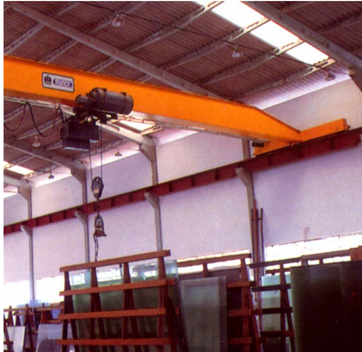
Figura 2.12 - Pilares com consolos para apoio de vigas de rolamento de pontes rolantes.
