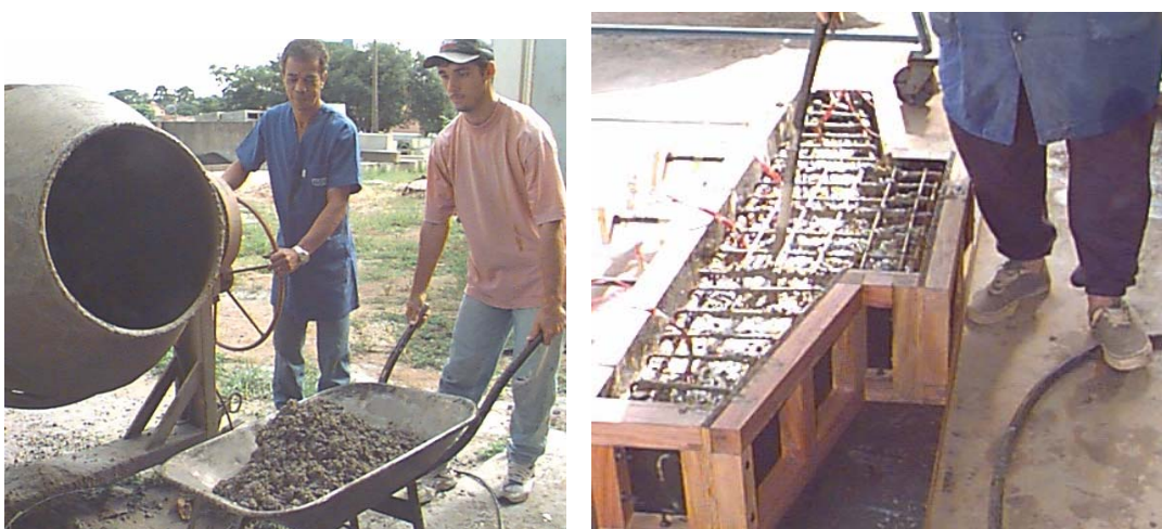
Figura 5.15 - Concretagem e adensamento do modelo.
