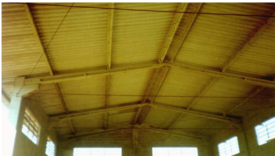
Figura 2.22 - Contraventamento longitudinal dos pórticos.
