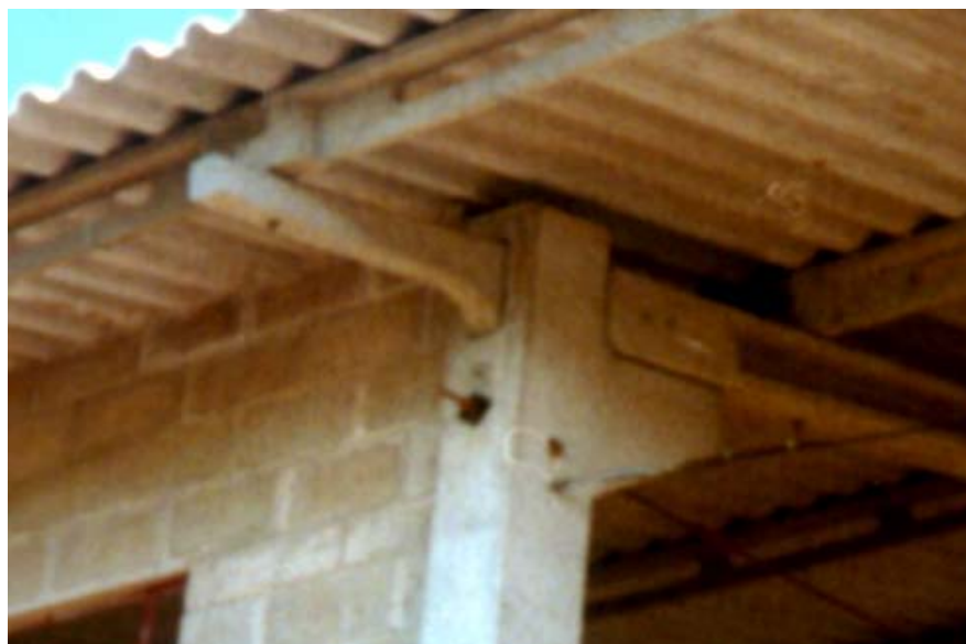
Figura 2.17 - Ligação viga-pilar - sistema passante.
