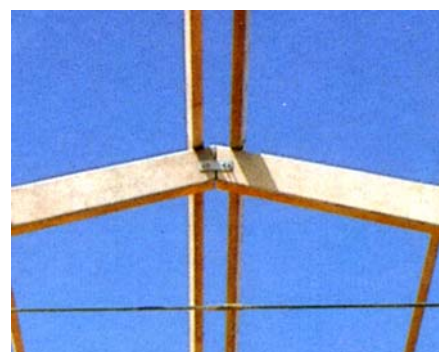
Figura 2.19 - Ligação viga-viga - chapa fixada nas faces laterais das vigas.
