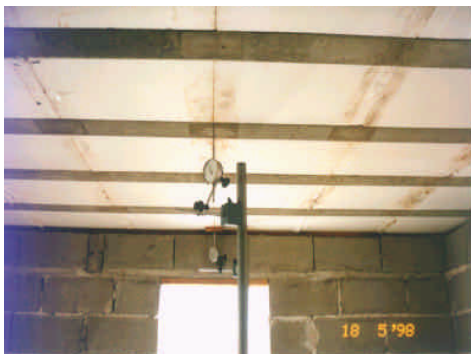
Fig.5.5 Posicionamento dos defletômetros
