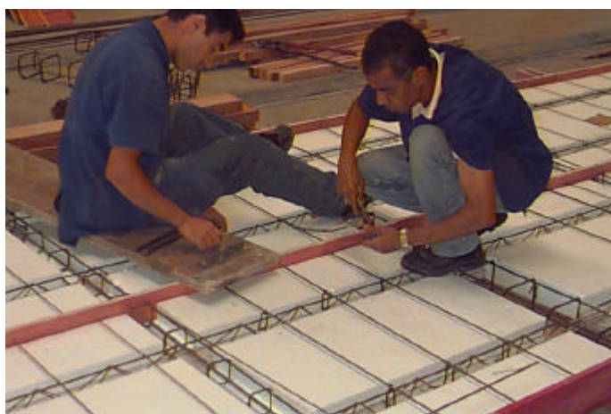
FIGURA 4.14 – Fixação da armadura de distribuição
