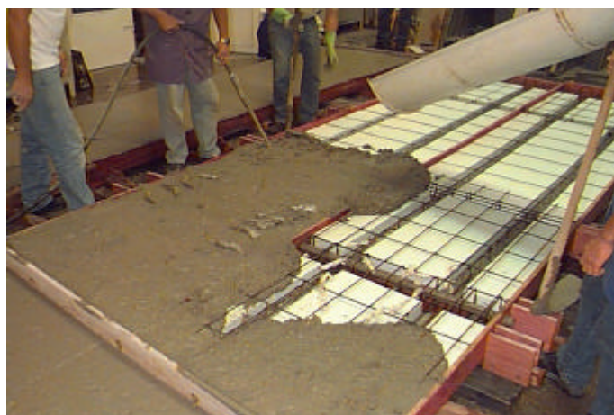
FIGURA 4.16 – Lançamento e adensamento do concreto
