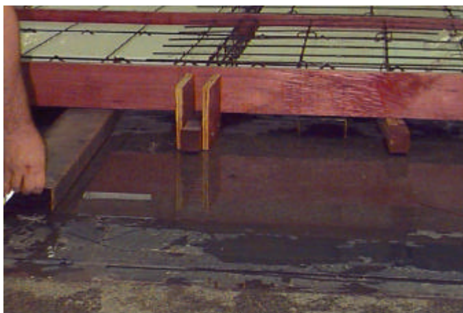
FIGURA 4.17 – Improvisação do escoramento dos blocos de EPS no dia da concretagem
