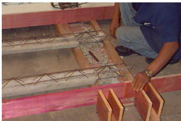
FIGURA 4.12 – Posicionamento das vigotas pré-moldadas
