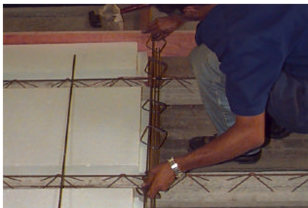
FIGURA 4.13 – Colocação dos elementos de enchimento e fixação das nervuras transversais
