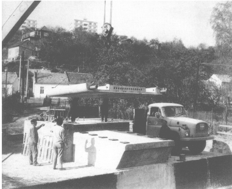
Figura 34 – Montagem do elemento de extremidade. (STRASKY & PIRNER, 1986)
