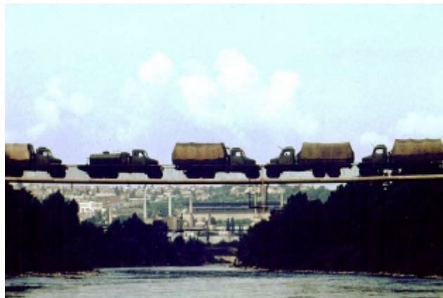
Figura 40 – Prova de carga. (STRASKY, 1999)
