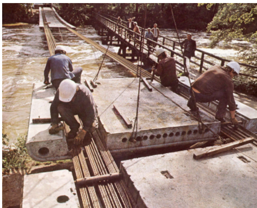
Figura 36 – Inserção de dispositivos para fixação do elemento aos cabos. (STRASKY & PIRNER, 1986)
