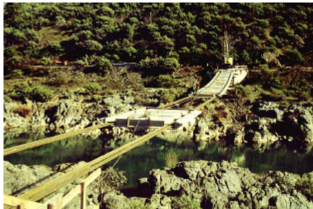
Figura 7 - Montagem de um segmento típico, Redding, EUA. (STRASKY, 1999)
