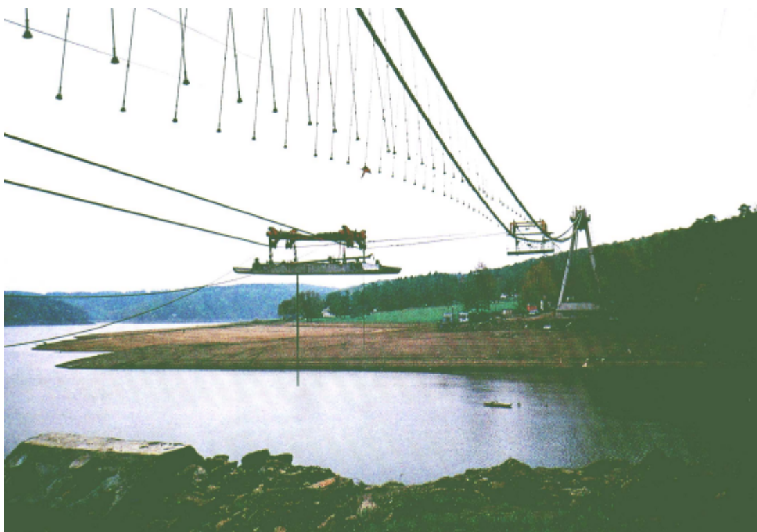
Figura 59 – Montagem do primeiro elemento do tabuleiro. (STRASKY & HUSTY, 1998)
