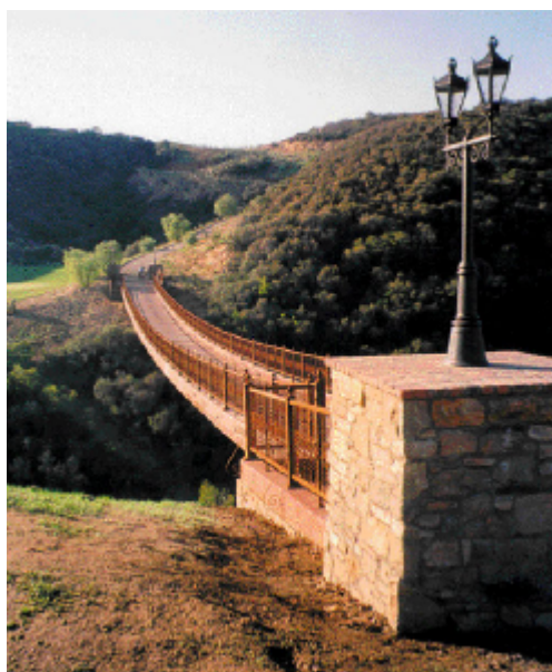
Figura 4 - Passarela em San Diego, EUA. 1
