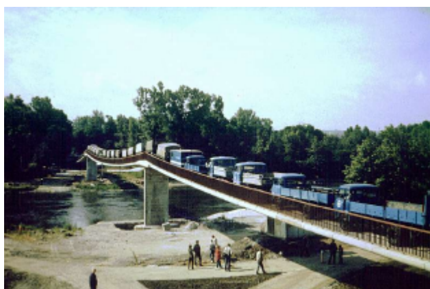
Figura 39 – Prova de carga. (STRASKY, 1999)
