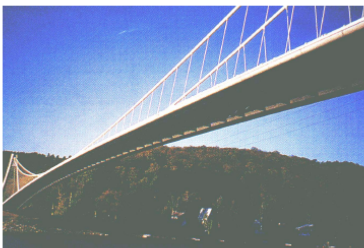
Figura 52 – Passarela sobre o lago Vranov. (STRASKY, 1997)
