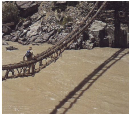
Figura 1 – Passarela pênsil primitiva. (DETAIL, 1999a)
