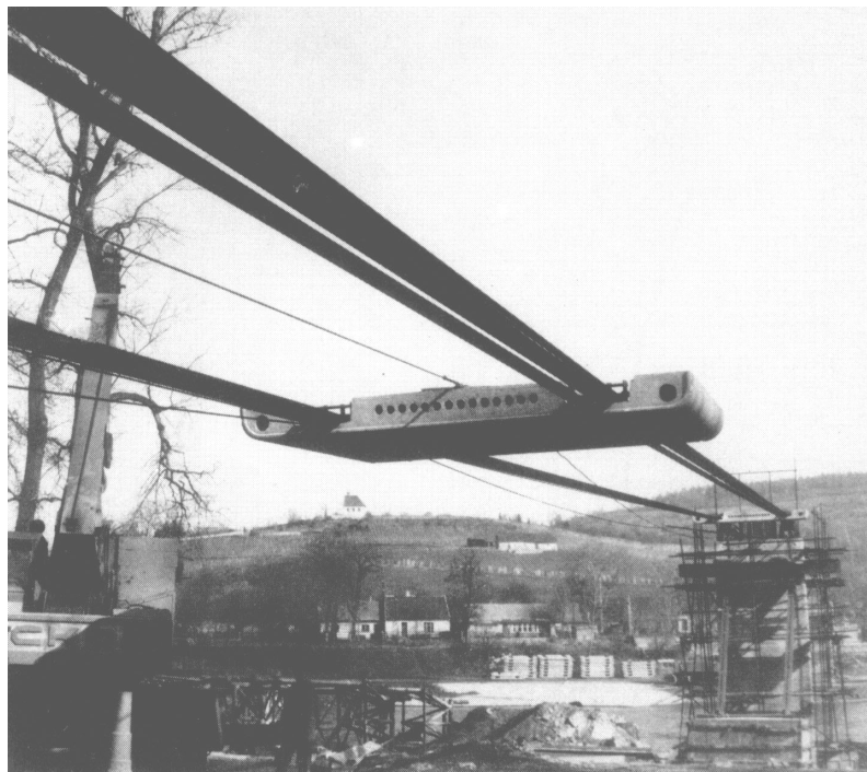
Figura 21 – Elemento pré-moldado sobre os cabos de sustentação. (STRASKY & PIRNER, 1986)
