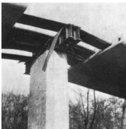
Figura 30 – Passarela em Prerov – sela de aço. (STRASKY & PIRNER, 1986).
