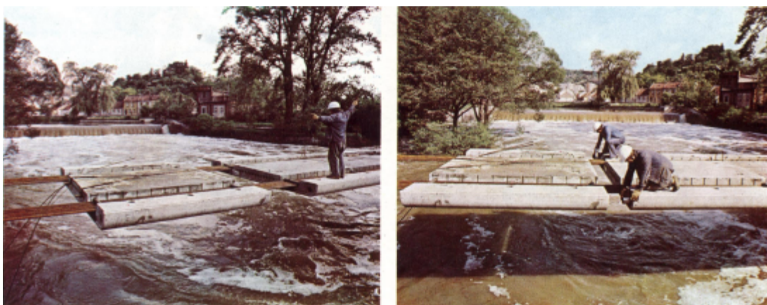
Figura 38 – Colocação de tubos de aço entre os elementos. (STRASKY & PIRNER, 1986)
