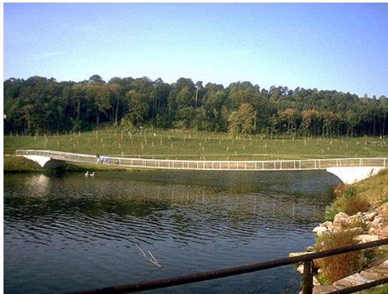
Figura 5 - Passarela sobre o Rio Enz, Alemanha. 2
