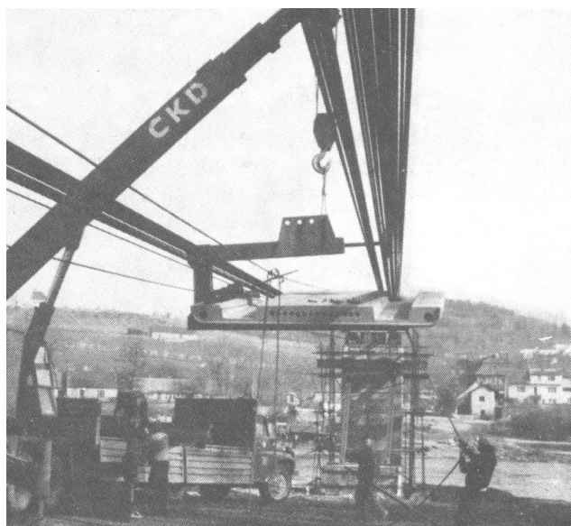
Figura 35 – Içamento de um elemento do primeiro vão. (STRASKY & PIRNER, 1986)
