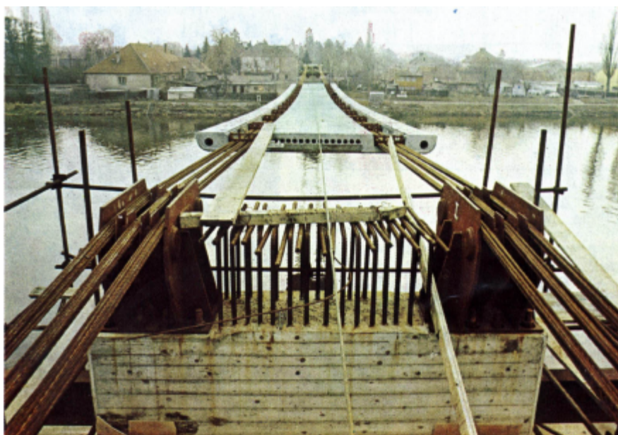
Figura 33 – Passarela em Nymburk – pilar intermediário com sela de aço. (STRASKY & PIRNER, 1986)
