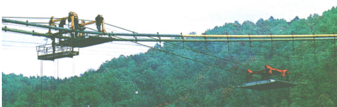
Figura 60 – Montagem do segundo elemento. (STRASKY & HUSTY, 1998)
