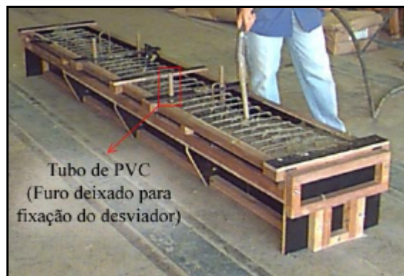
Figura 4.14 - Concretagem da viga VP-1
