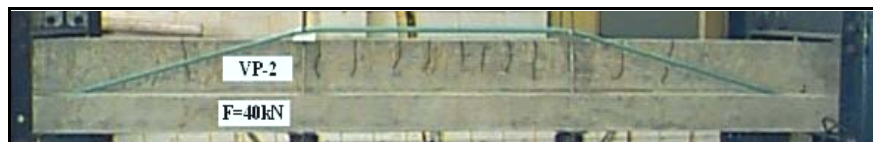
Após a protensão dos cabos.
