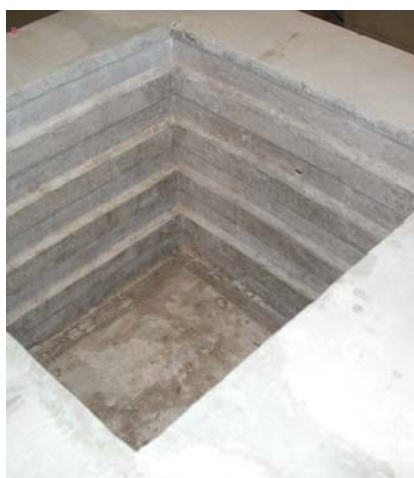
4º) Região interna do cálice depois do acabamento final feito com lixa
