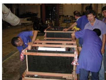
2º) Colocação da parte interna da fôrma
