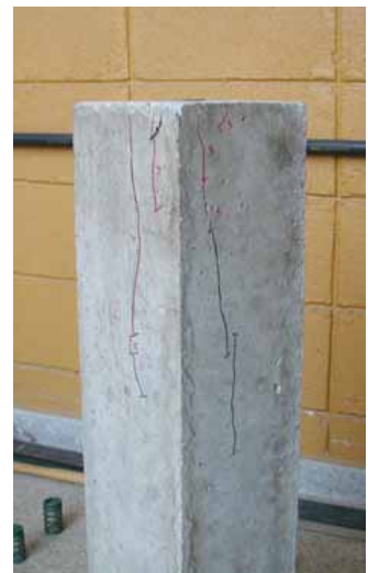
Figura 5.29 – Prisma prB após a ruptura.
