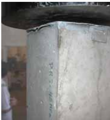
Figura 6.34 – Regularização da superfície com massa plástica.
