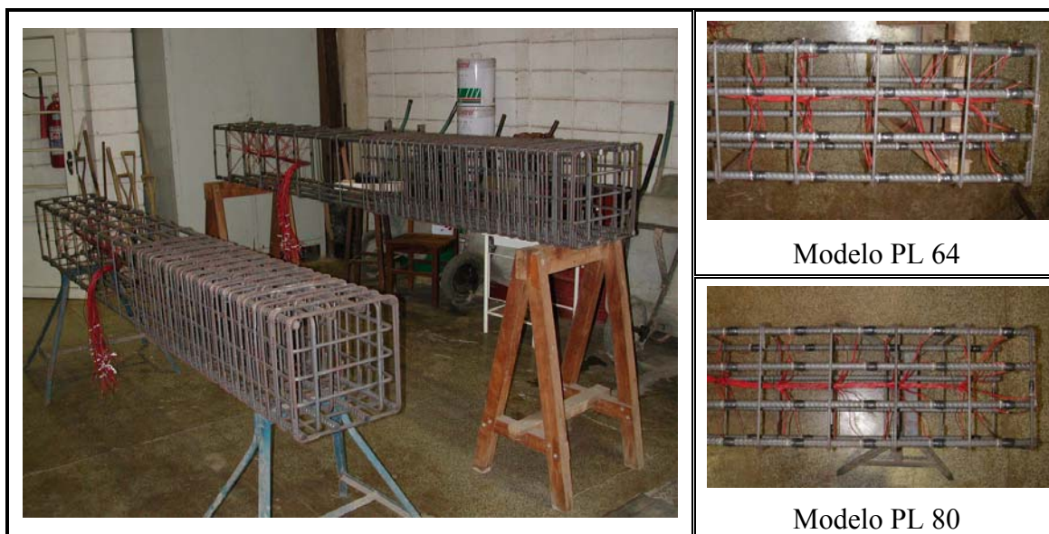
Figura 3.7 – Configuração final da armadura
