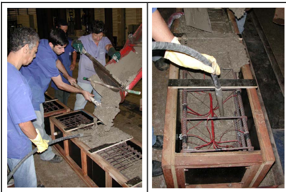
Figura 3.10 – Concretagem dos pilares
