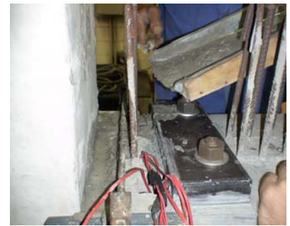
Grauteamento entre viga/pilar e rasgo da viga
