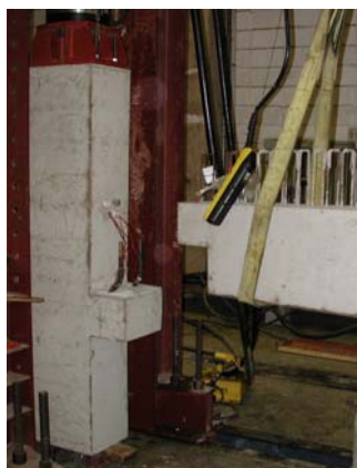
Posicionamento da viga
