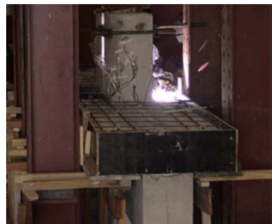
Soldagem da armadura da capa
