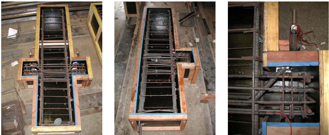
Figura 3.12 – Armação dos pilares dos modelos I e E
