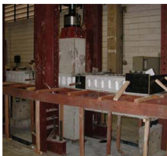
Fôrma para concretagem entre as lajes
