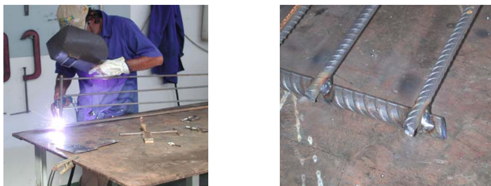
Figura 3.10 - Soldagem dos tirantes das vigas e dos pilares
