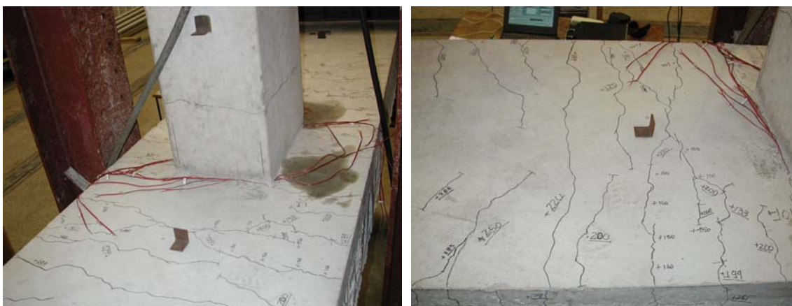
Figura 4.2 - Fissuração da capa de concreto do modelo I
