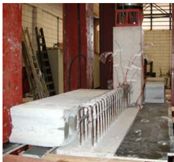
Posicionamento das lajes
