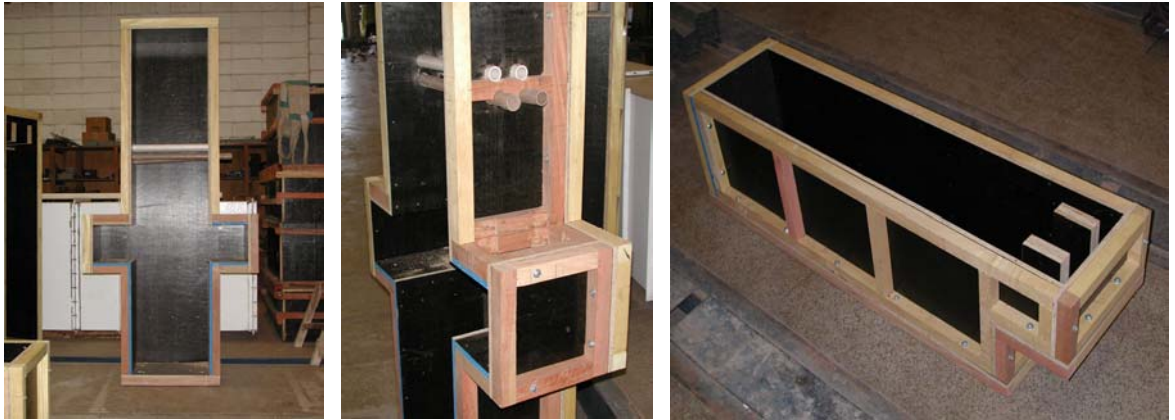
Figura 3.11 - Fôrmas das vigas e do pilar
