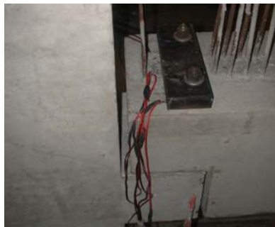
Fixação da chapa metálica
