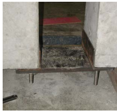
Detalhe da chapa e cantoneira inferior
