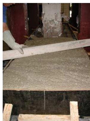
Concretagem da capa
