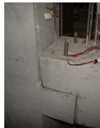
Viga apoiada no consolo
