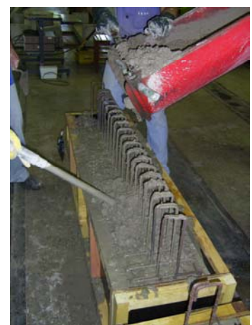
Concretagem da viga
