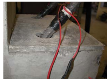
Detalhe da almofada de apoio sobre o consolo
