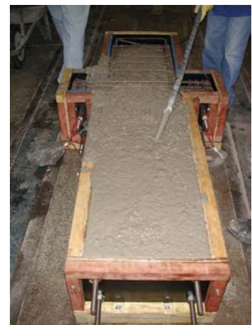
Concretagem do pilar
