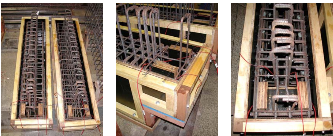
Figura 3.13 - Armação das vigas
