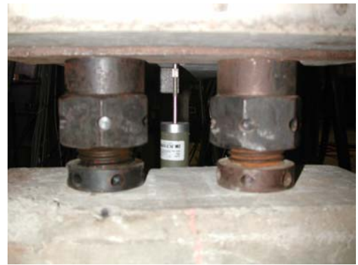
Detalhe da estrutura de apoio inferior
