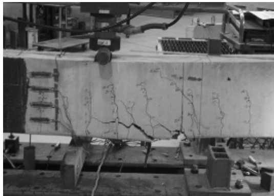
Figura 3.2 - Destacamento do concreto de cobrimento iniciado na extremidade do reforço (Fonte: adaptado de De Lorenzis e Teng (2006)).
