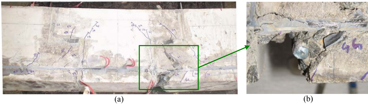
Figura 7.25 - (a) Configuração das fissuras após a ruptura; (b) detalhe da armadura exposta - modelo N1 CJ.
