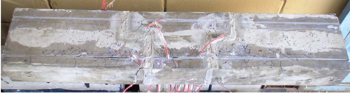
Figura 7.23 - Configuração das fissuras após a ruptura do modelo-piloto de ligação.
