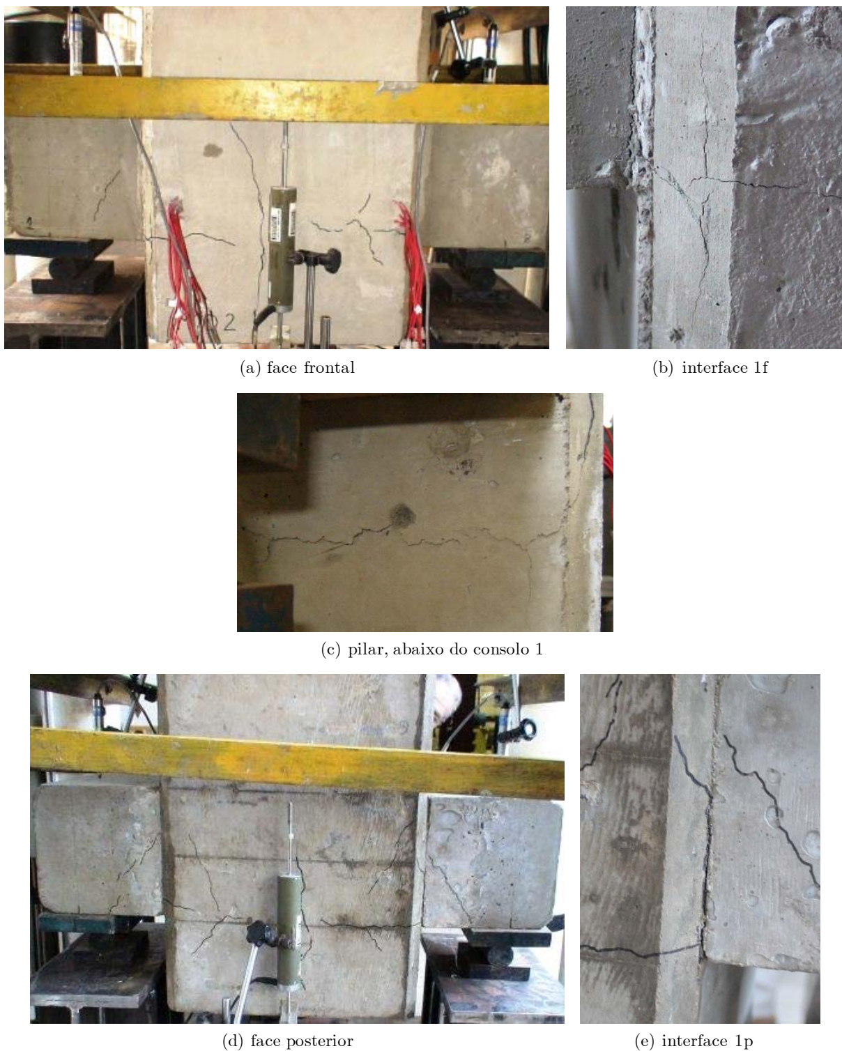
Figura 4.9 - Quadro de fissuração do modelo MBC2.
