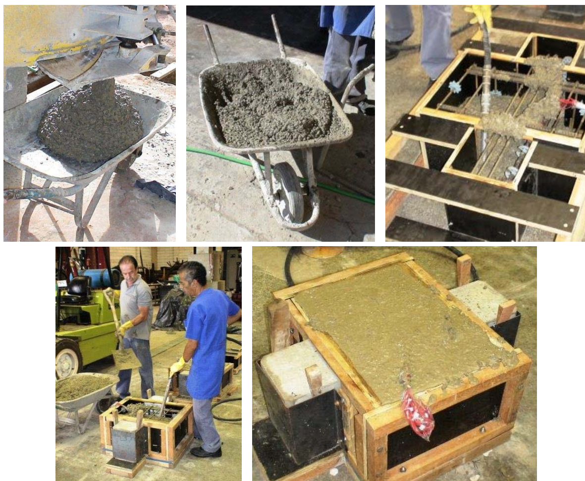
Figura 3.37 - Detalhes da concretagem dos trechos de pilar.
