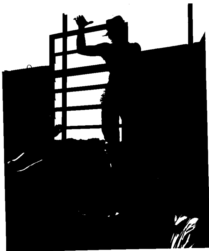
FIG. 114. ENCAIXE DA JANELA.
