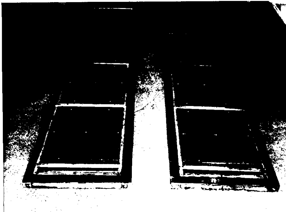
FIG. 39. FÔRMA E ARMADURA DAS FACES.
