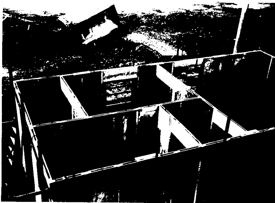
FIG. 124. ARMADURA DA CINTA DE AMARRAÇÃO E CHUMBADORES POSICIONADOS.
