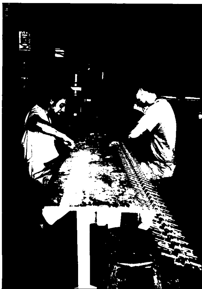
FIG. 54. PREPARO DAS ARMADURAS.
