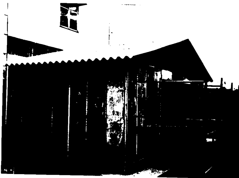
FIG. 148. A PLACA DE VEDAÇÃO É FIXADA NOS ELEMENTOS DA ESTRUTURA METÁLICA.
