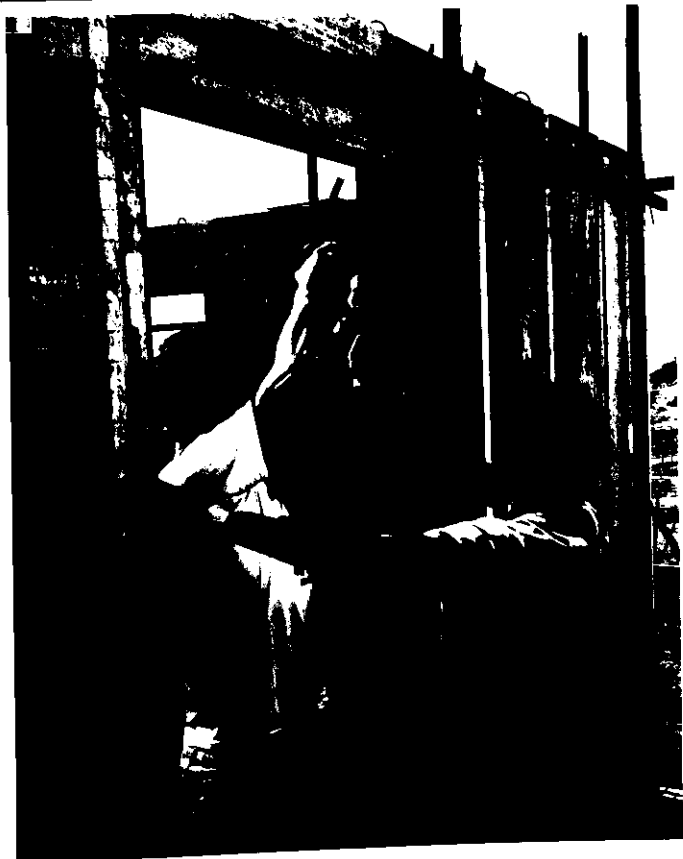
FIG. 127. FIXAÇÃO COM BUCHAS E PA- FUSOS.
