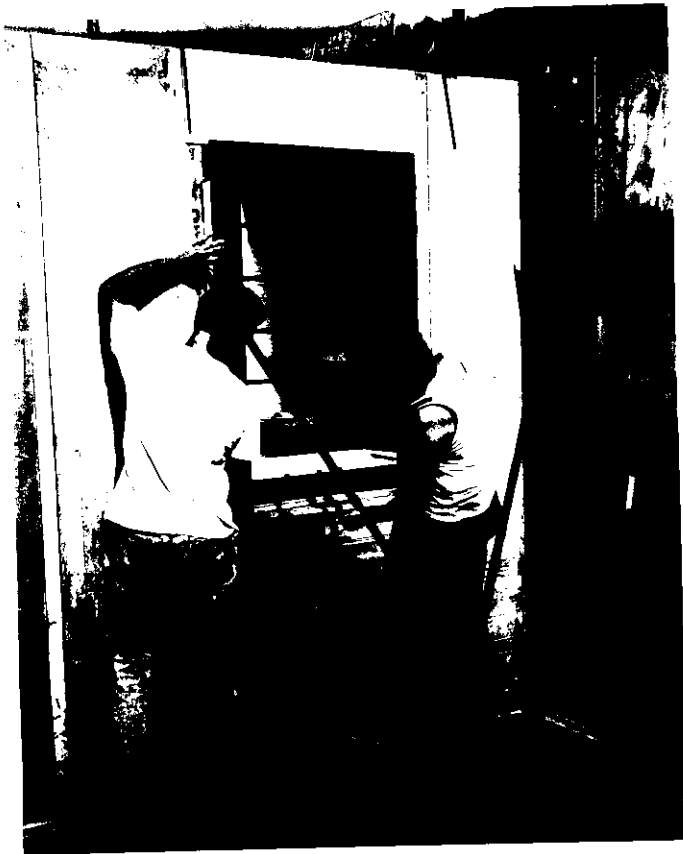
FIG. 126. POSICIONAMENTO DAS PORTAS.
