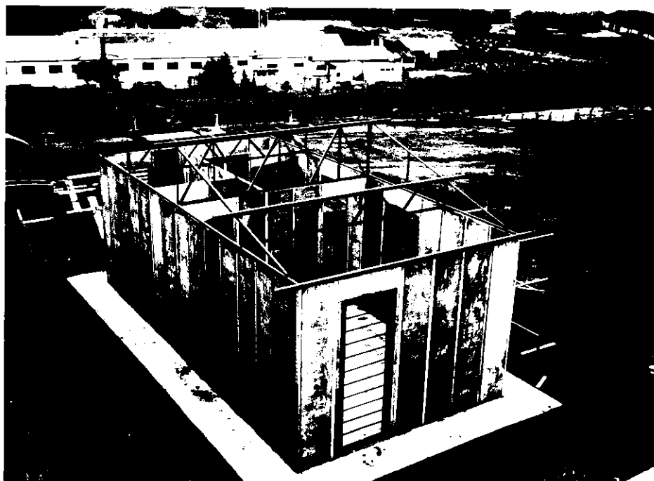
FIG. 142. A ESTRUTURA DA COBERTURA.
