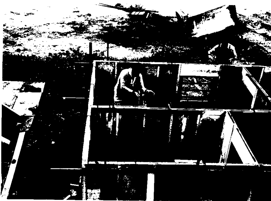
FIG. 125. CONCRETAGEM DA CINTA.
