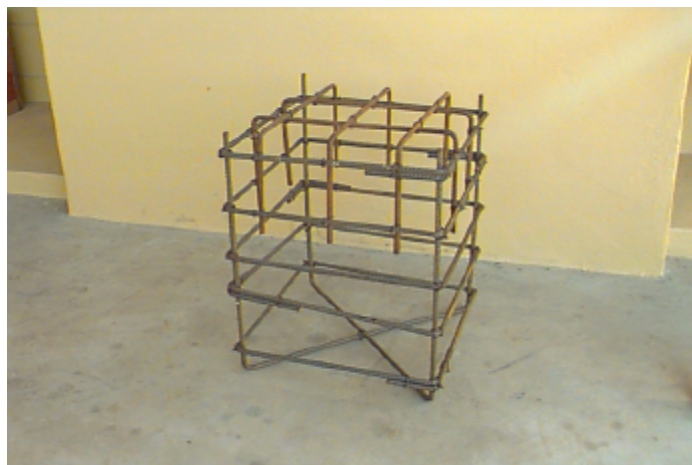
Figura 4.12 – Foto da armadura do elemento de bloco
