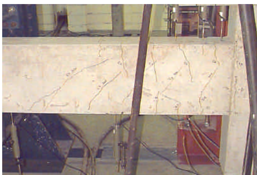
Figura 5.29 – Fissuras no lado esquerdo do Protótipo Monolítico
