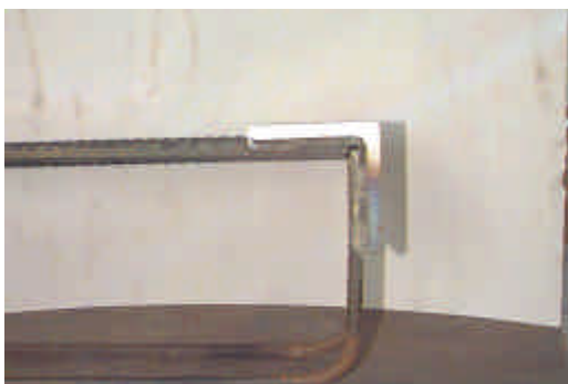
a) Detalhe da ligação com solda na armadura do consolo
