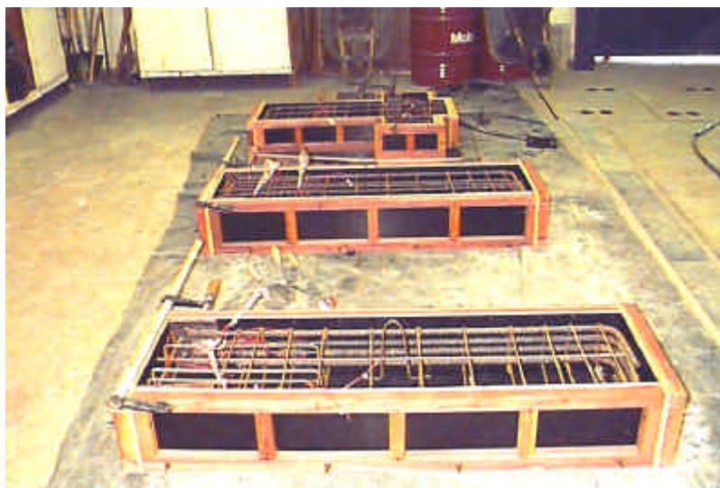
Figura 5.14 – Preparação para a concretagem dos elementos que compõem o protótipo com ligações soldadas.
