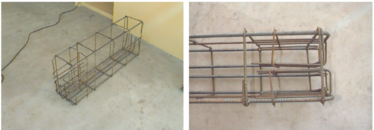
Figura 4.10 – Foto da armadura utilizada no elemento de viga
