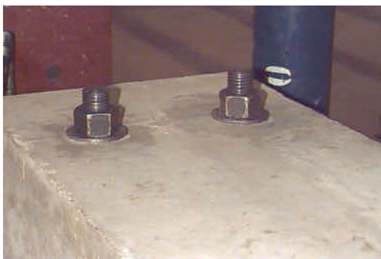
Figura 4.31 – Travamento dos chumbadores com porcas e arruelas
