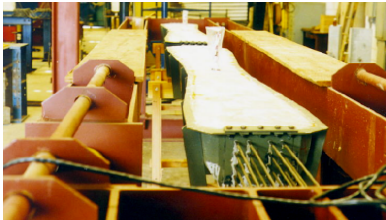
Fig. 7.7 - Estrutura de protensão com dois dormentes concretados.
