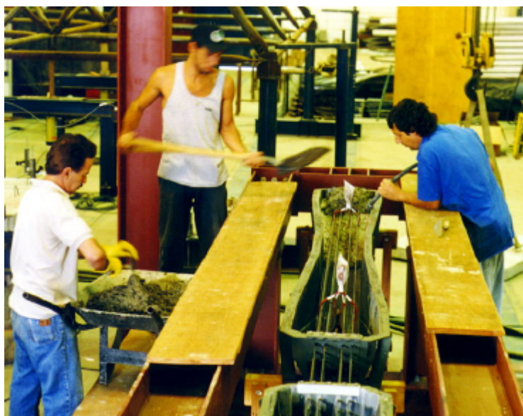
Fig. 7.14 - Operações de lançamento e de adensamento do concreto.
