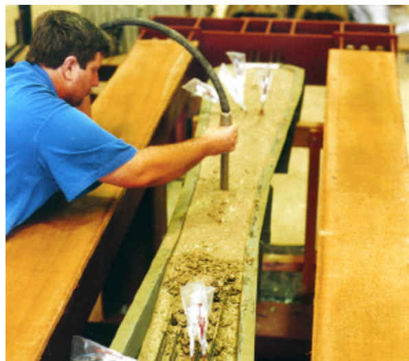
Fig. 7.17 - Adensamento do concreto com vibrador de agulha
