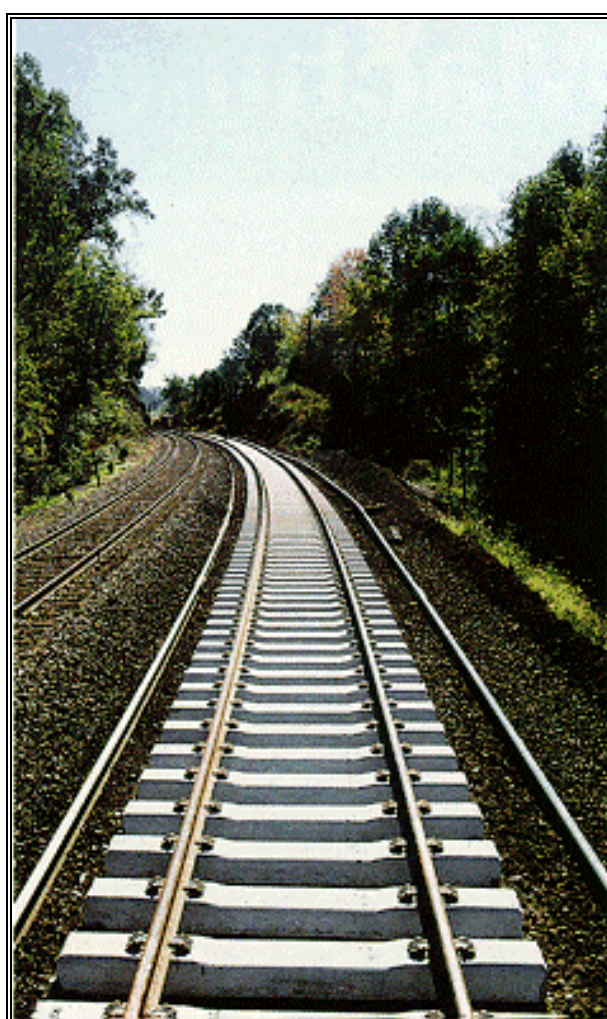
Fig. 2.2 - Via com dormente monobloco. (FONTE: TRACK REPORT - PANDROL, 1996).
