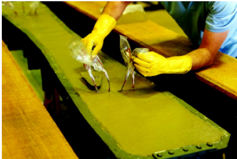
Fig. 7.18 – Acabamento da superfície do concreto.
