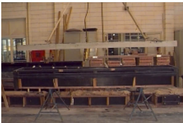
(f) Posicionamento da laje pré-moldada sobre a viga pré-moldada
