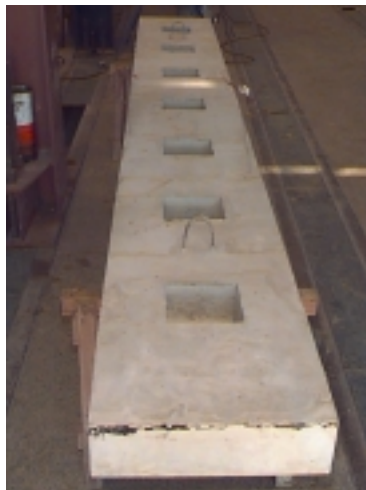
(d) Laje pré-moldada com nichos
