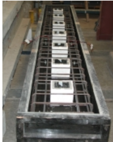
(b) Fôrma da laje pré-moldada
