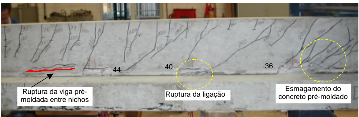
(b) Detalhe da V3 mostrando a ruptura da ligação e do concreto pré-moldado
