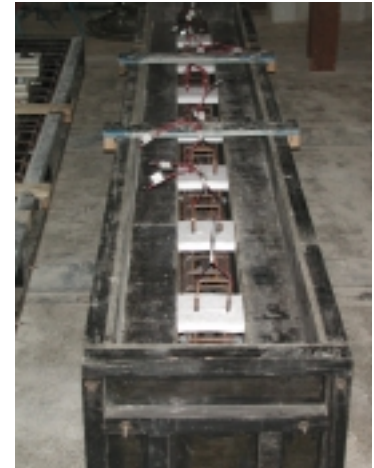
(c) Fôrma da viga pré-moldada
