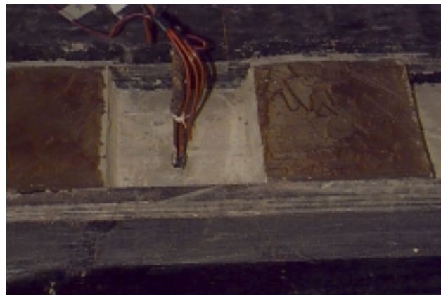
(e) Face superior da viga pré-moldada com chave de cisalhamento e conector - superfície engraxada para evitar atrito
