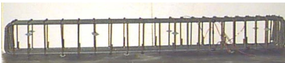
(a) - armadura das vigas;
