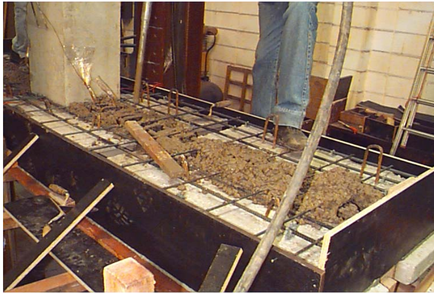
Figura 4.65 - Concretagem da capa (modelo 2.1).
