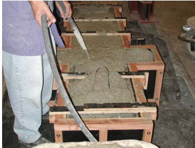
(e) - concretagem do pilar;
