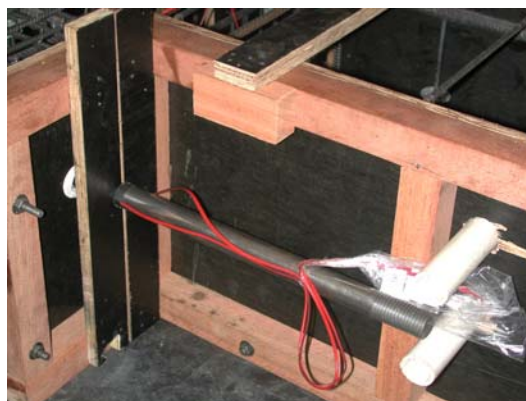
Figura 4.52 - Armadura na fôrma do pilar.
