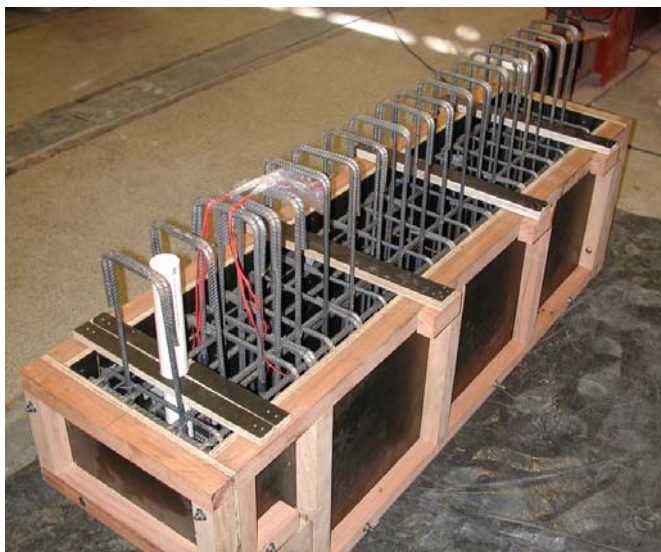
Figura 4.51 - Armadura na fôrma da viga (modelo 2.1).
