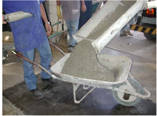
(b) - concreto sendo depositado nas carriolas;
