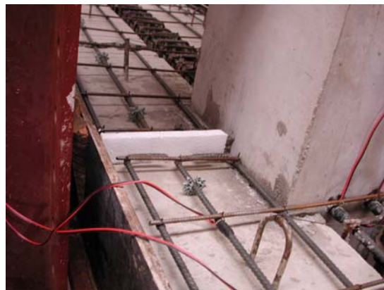
Figura 4.64 - Solução para garantir a descontinuidade da capa do modelo 2.2.
