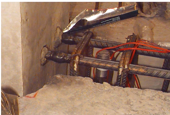
Figura 4.60 - Grauteamento dos furos do pilar.
