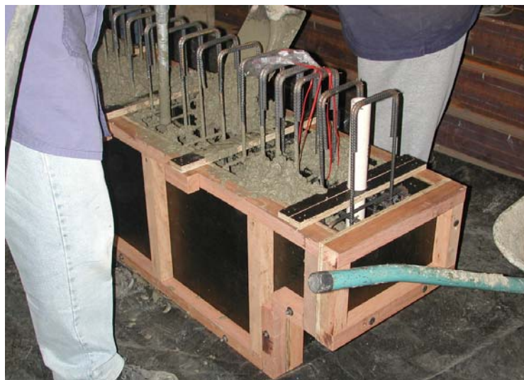
(d) - concretagem das vigas;
