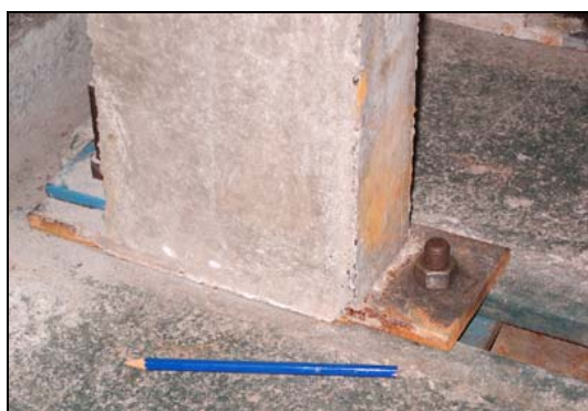
Figura 5.30. Detalhe da fixação dos pórticos.
