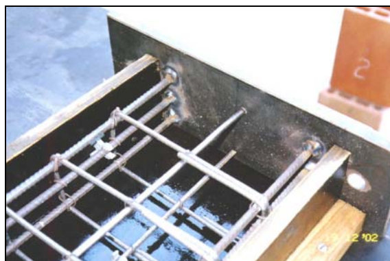
Figura 5.13. Conjunto base metálica - armadura do pilar (montada na fôrma).
