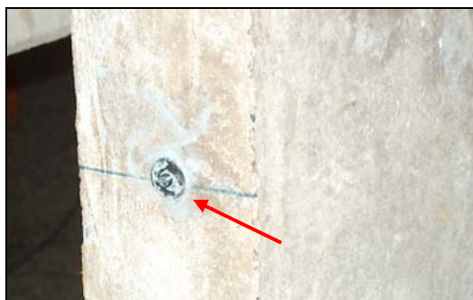
(b) - Parafuso de fixação do excitador não perpendicular à superfície do modelo
