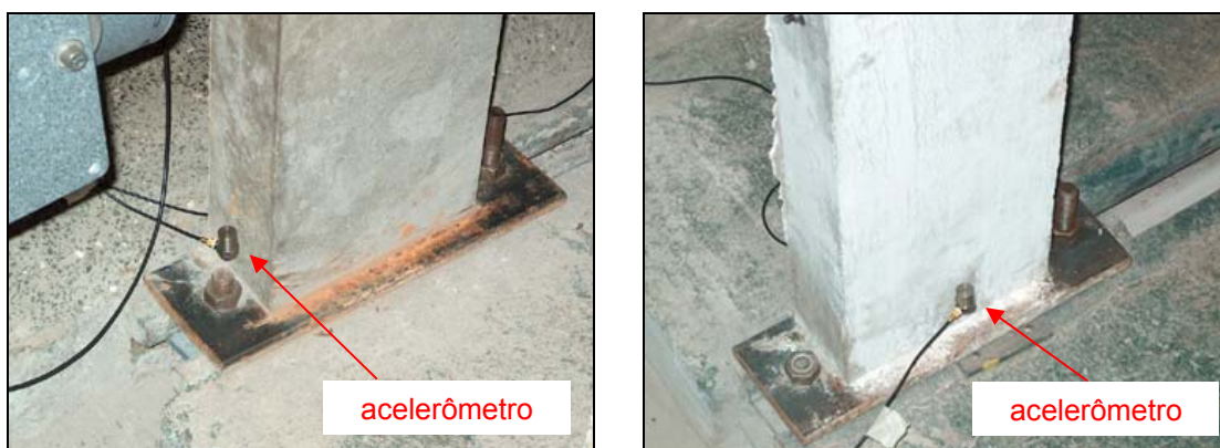
Figura 7.24. Posicionamento dos acelerômetros nas laterais do pilar.
