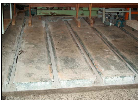
(c) Laje de reação do LabDin-SEM
