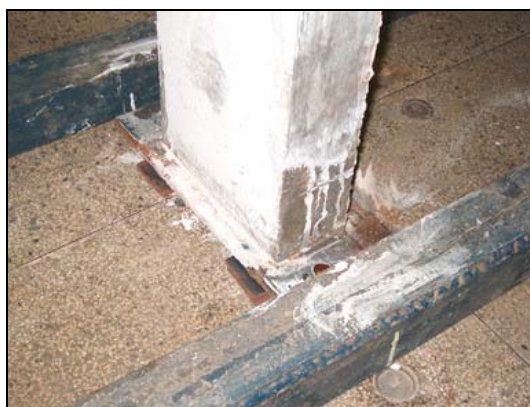
Figura 5.20. Detalhe do apoio do modelo durante o ensaio de fissuração.
