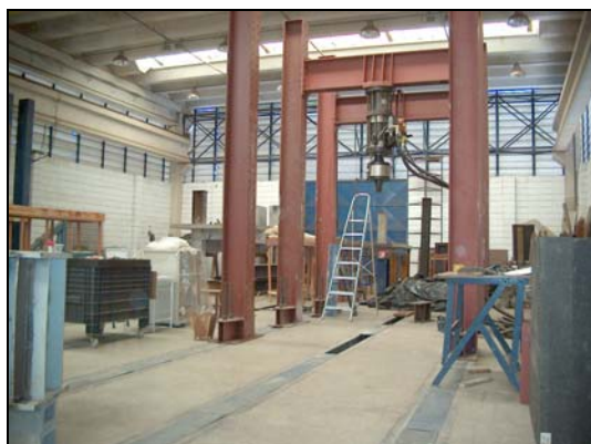
(a) Laje de reação principal do LE-SET
