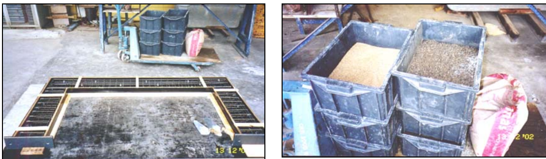
Figura 5.9. Materiais utilizados na construção dos modelos.
