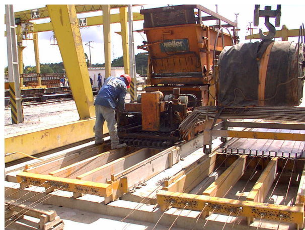
Figura AP-D-16 – Início concretagem
