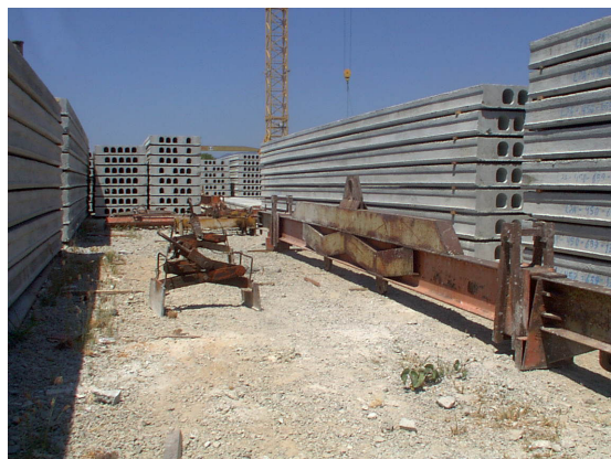
Figura AP-D-8 – Viga metálica e prensas
