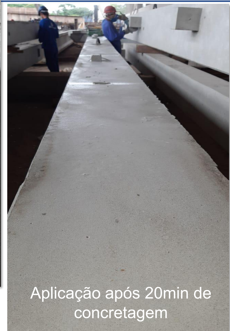
Aplicação do CURA QUIMICA logo após concretagem
