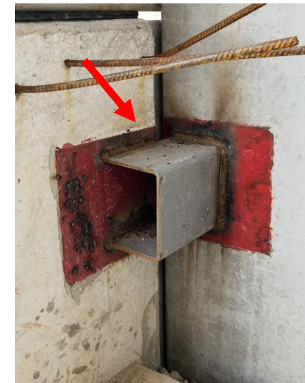
DETALHE DE SOLDA DO PERFIL U - U130X170X8X200 ESC.: 1:25 PAINÉIS POR FORA DOS PILARES
