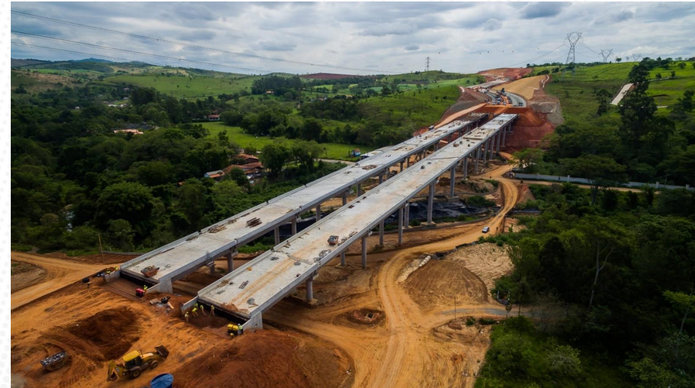
Viaduto Rodovia Carvalho Pinto - SP
