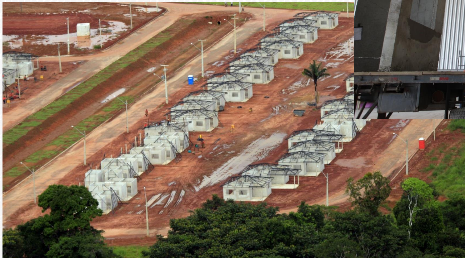
Obra Nova Mutum Paraná – RO (Usina de Jirau)
