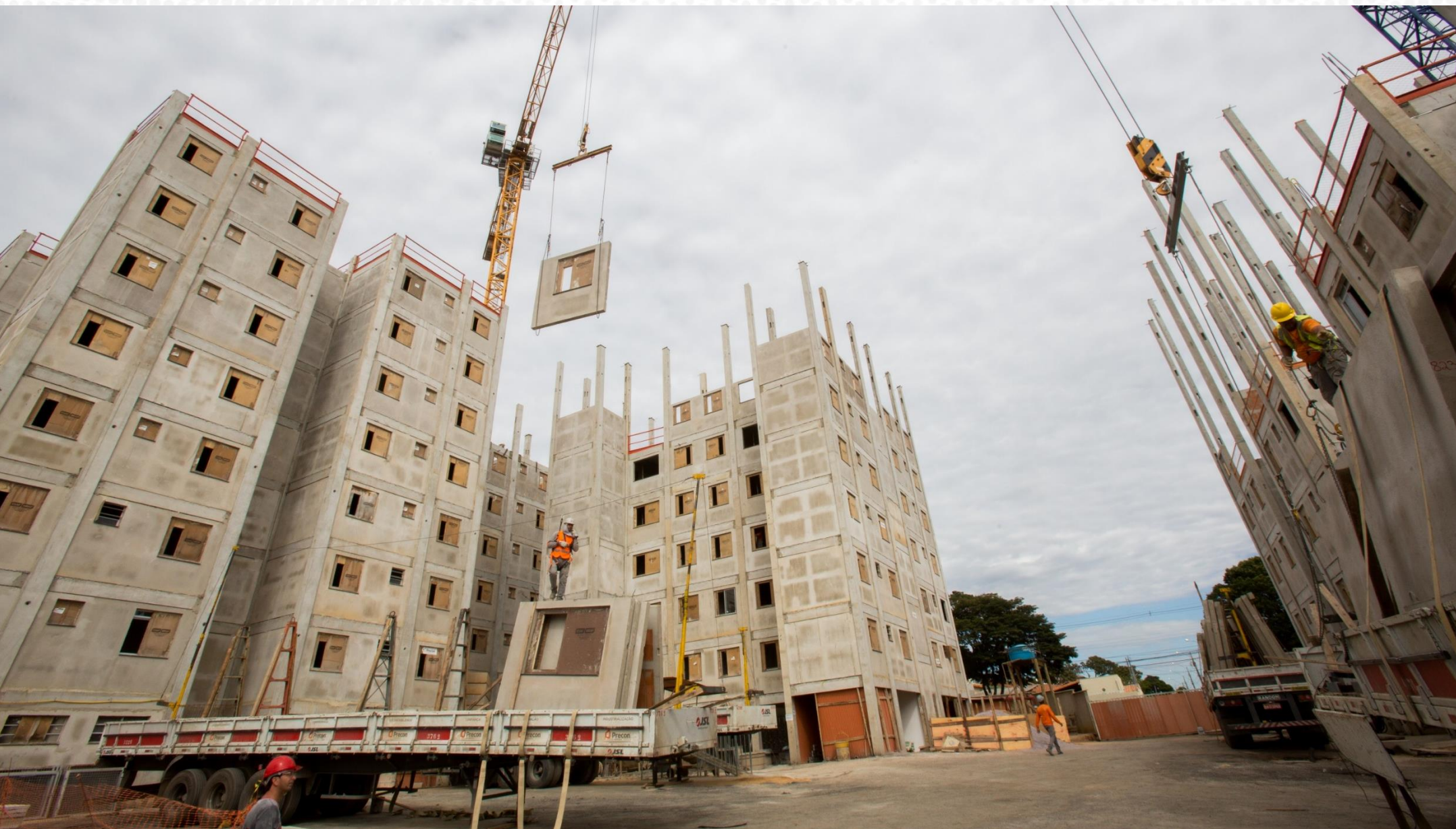
Empreendimento Ville Santiago – Sete Lagoas –MG
