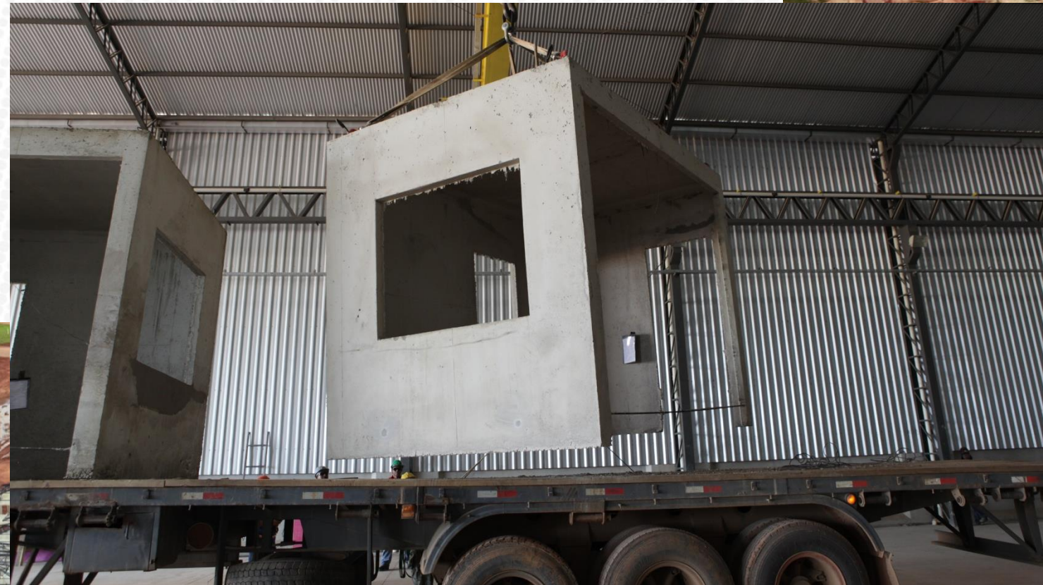
Módulos pré-fabricados de concreto (sala estar casa)
