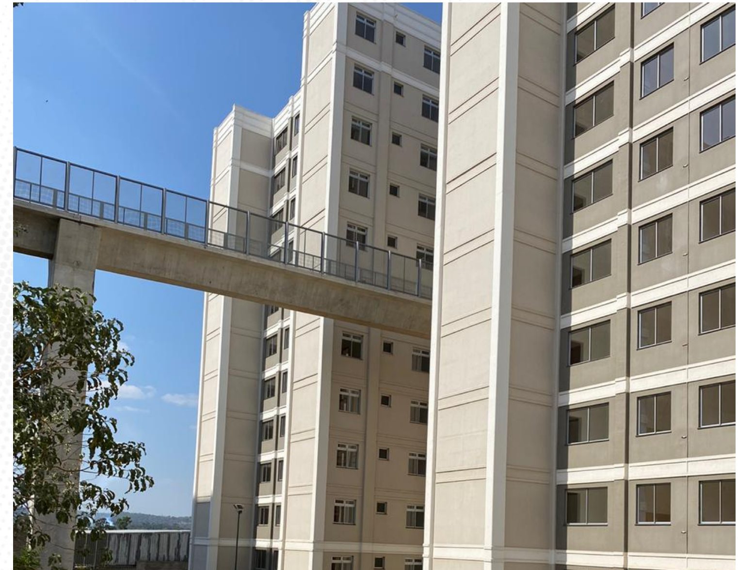
Passarela pré-fabricada – viga de concreto com 15m de comprimento
