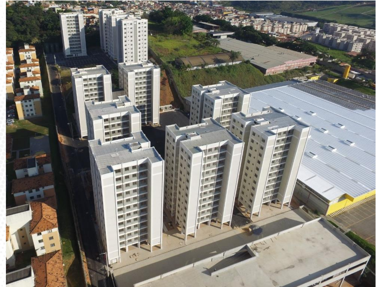
Empreendimento Ville Toronto – Santa Luzia –MG
