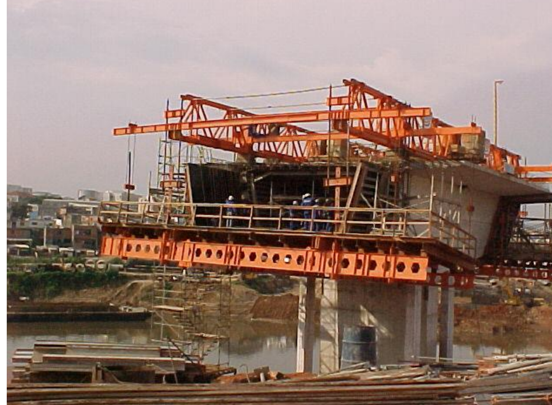
Ponte sobre o Tiete Rodoanel Oeste - 2000 Moldada in loco - Vão de 120m
