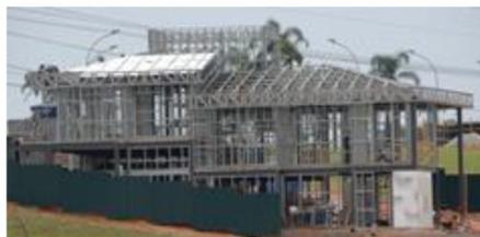
*Figura 3: Habitação Unifamiliar – Sistema construtivo em light steel framing (Font: Saint-Goban)*
