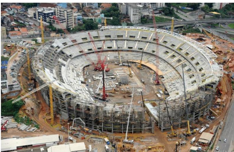
Figura 63: Estádio Arena Fonte Nova durante a montagem da estrutura pré-moldada
