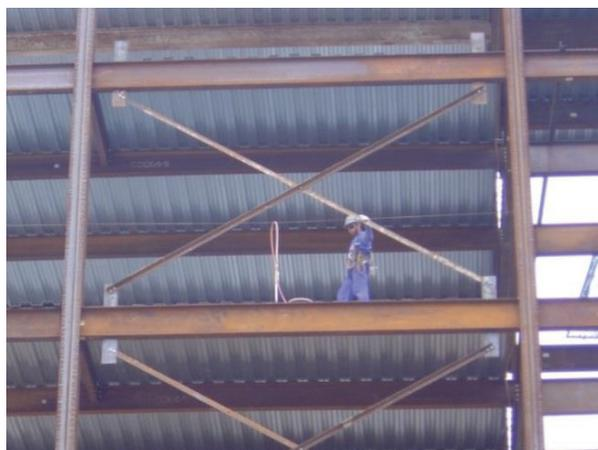
Figura 30: Steel deck aplicado na obra (Imagem: arquivo CBCA)
