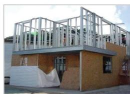
Figura 44: Vedaç o com Placas OSB e MCMV – Paran  (Fonte: Siding (Fonte: CBCA)
