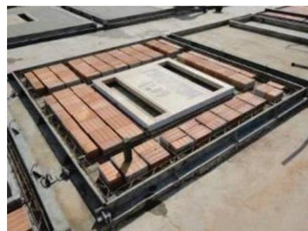
Figura 100: Modulação dos blocos cerâmicos com esquadria para concretagem. (Fonte: DATec Jet Casa N 008-A, 2014)
