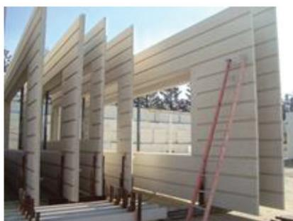
*Figura 1: Painéis de vedação pré-fabricados de concreto (Fonte: ABCIC)*
