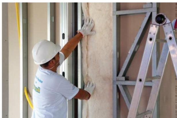
Figura 48: Detalhe de isolamento de vedações em light steel framing (Fonte: Saint-Gobain)
