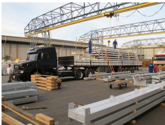
*Figura 38: Embarque de estruturas de aço em caminhão (Foto: Sidnei Palatnik)*
