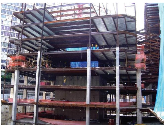
Figura 33: Vista de fachada com os pilares mistos em processo de concretagem
