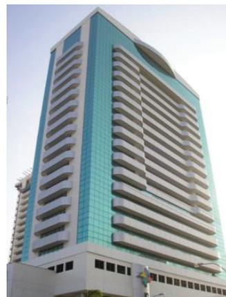
*Figura 72: Empreendimento Pátio Dom Luís em Fortaleza (CE), composta de vigas e lajes pré-fabricadas protendidas e pilares moldados no local e torres de 20 e 24 pavimentos*
