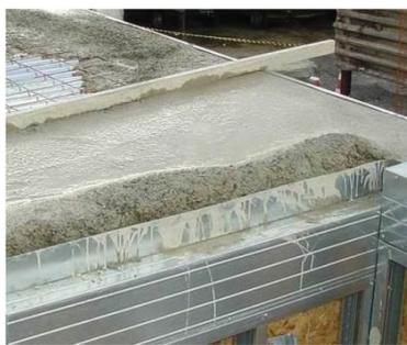
Figura 52: Laje Úmida (Fonte: CBCA)
