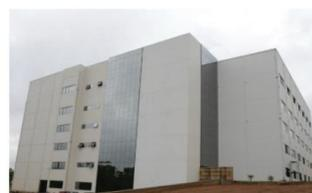
Figura 47: Fachada em light steel framing com vedaç o em Placas Ciment cias (Fonte: Saint-Gobain)
