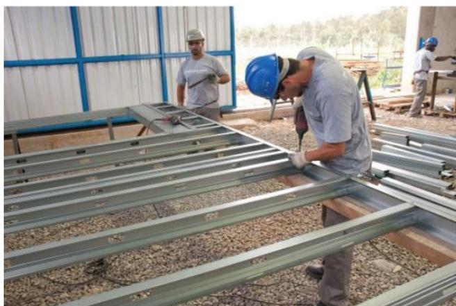
Figura 50: Sistema de painéis (Fonte: Construtora Micura)
