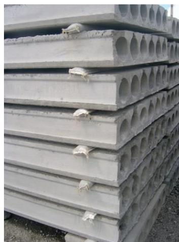
*Figura 82: Situações transitórias: armazenamento de lajes alveolares pré-fabricadas*
