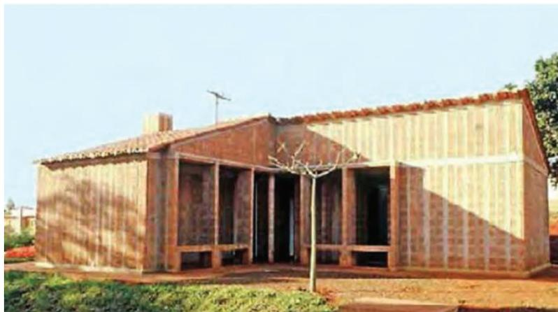
Figura 101: Primeira habitação experimental utilizando o painel cerâmico, na Unicamp, em 1986. (Fonte: Dualib, 2013)
