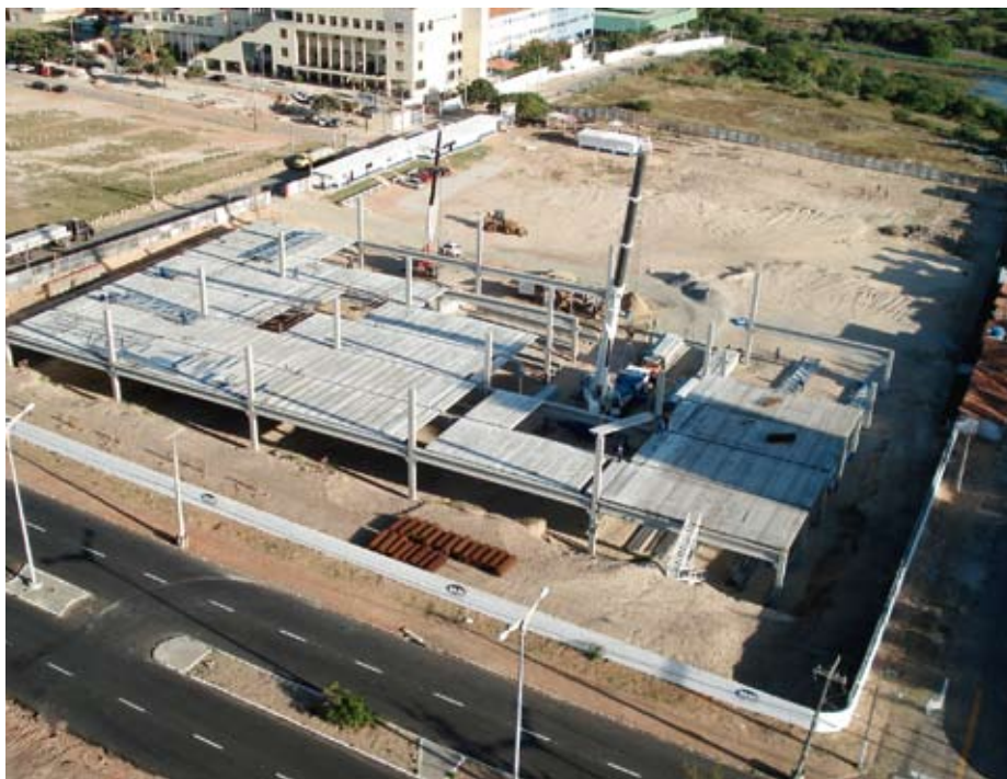
Obras de um shopping center construído no nordeste com lajes alveolares
