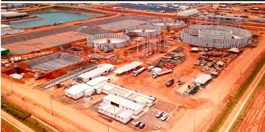
Os maiores desafios da obra da LD Celulose foram a execução dos tanques circulares e o edifício Cooling Tower, uma vez que a etapa de projetos exigiu a melhor solução em pré-fabricado
