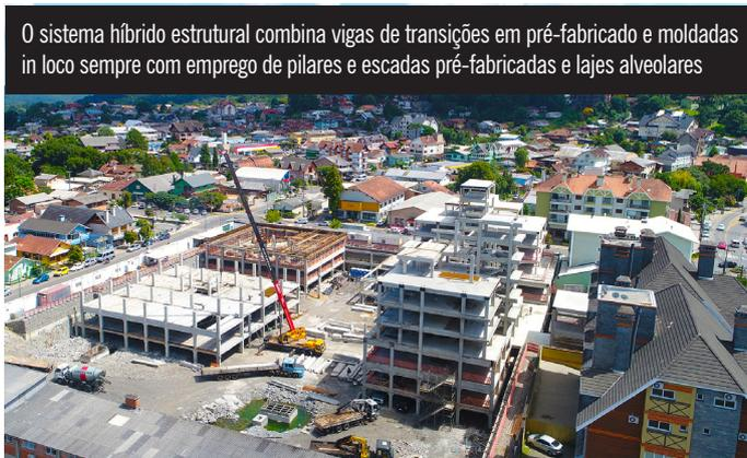
O sistema híbrido estrutural combina vigas de transições em pré-fabricado e moldadas in loco sempre com emprego de pilares e escadas pré-fabricadas e lajes alveolares
