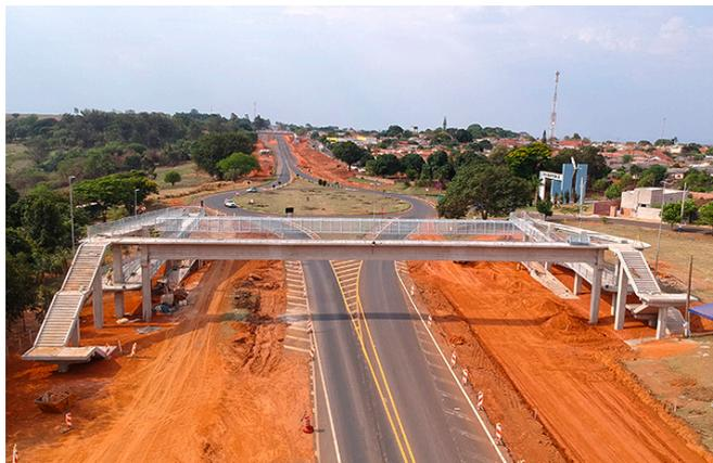
As vigas longarinas das passarelas na SP-333 foram seccionadas em três segmentos, transportadas separadamente e interligadas na obra, já na posição final
