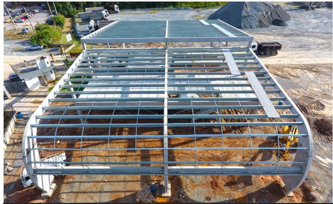
As estruturas dos pórticos curvos em pré-fabricados de concreto são o destaque arquitetônica da entrada da Geocal Minerações
