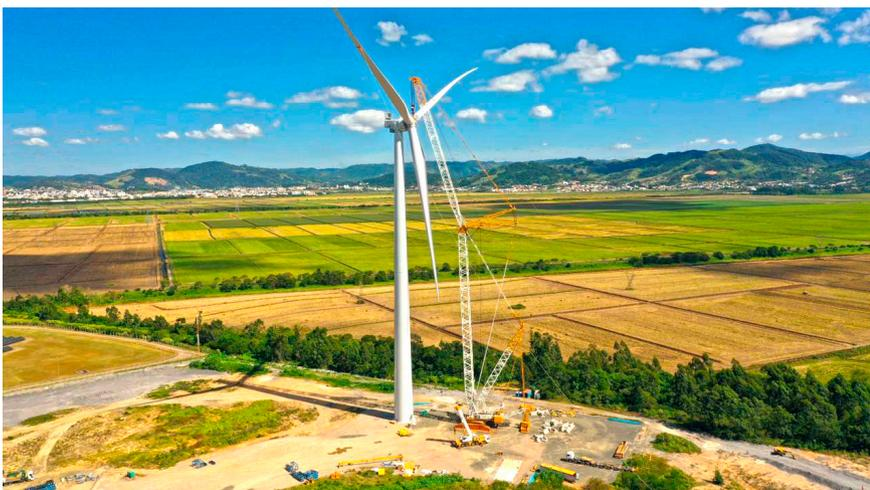
Após várias simulações, entre diversas concepções, a torre da Usina Eólica de Tubarão toda de concreto se mostrou mais adequada estruturalmente e financeiramente
