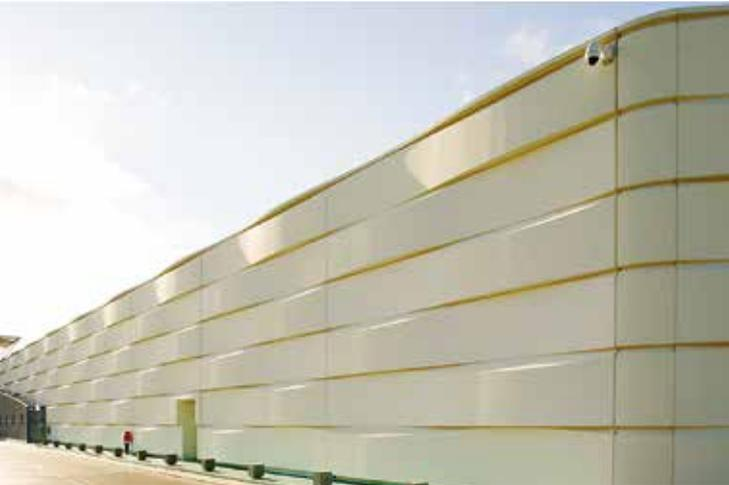
**Fig. 14. Painéis de concreto protendido para um centro comercial**
