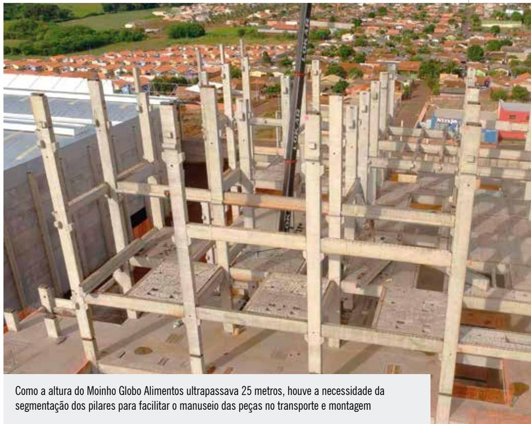
Como a altura do Moinho Globo Alimentos ultrapassava 25 metros, houve a necessidade da segmentação dos pilares para facilitar o manuseio das peças no transporte e montagem
