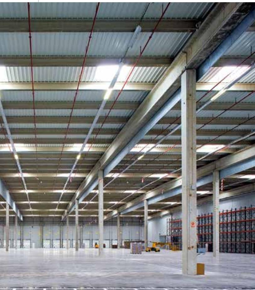
**Fig. 11. Centro de distribuição de concreto protendido. Visão interna**
