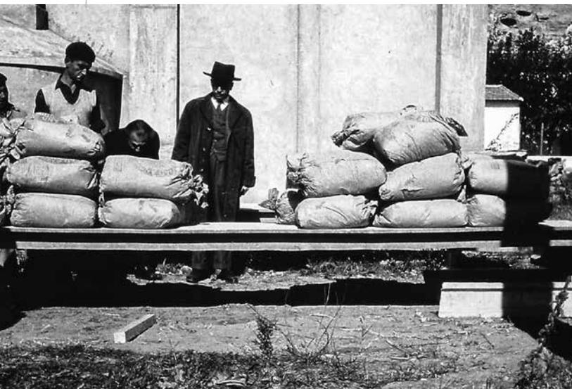
**Fig. 9. Francisco Fernandez Conde inspecionando testes em vigas de concreto protendido**
