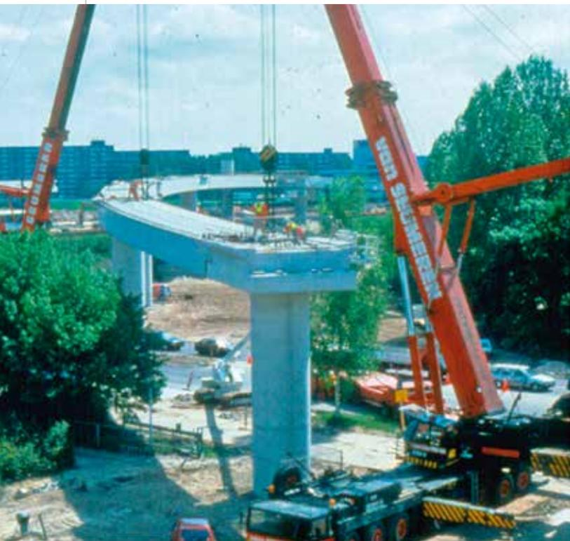
**Fig. 6. Ponte com vigas curvas de concreto protendido nos Países Baixos**
