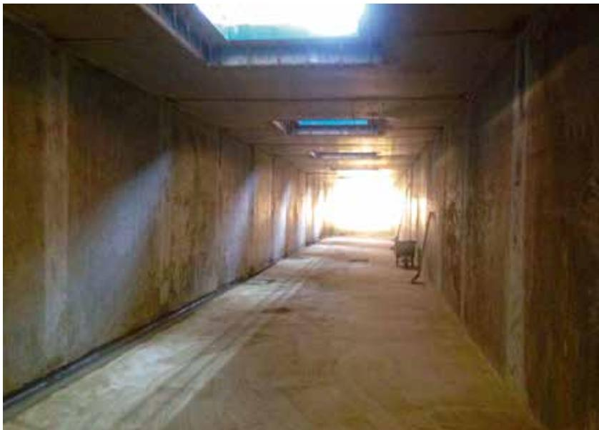
Um cuidado extra foi com o uso de um concreto altamente impermeável, devido a necessidade de absoluta estanqueidade no interior dos túneis
