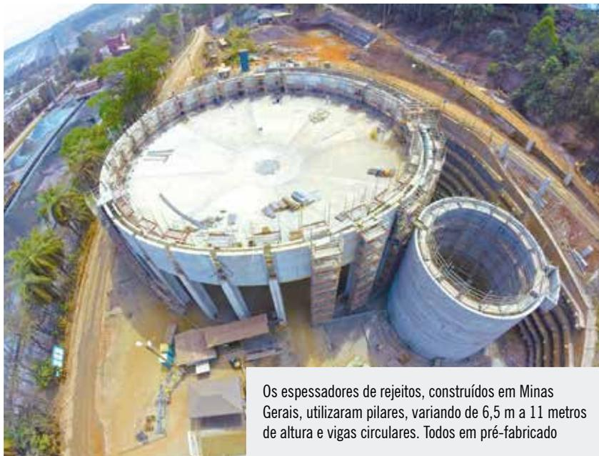
Os espessadores de rejeito, construídos em Minas Gerais, utilizaram pilares, variando de 6,5 m a 11 metros de altura e vigas circulares. Todos em pré-fabricado
