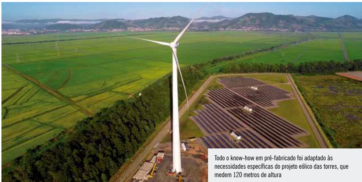
Todo o know-how em pré-fabricado foi adaptado às necessidades específicas do projeto eólico das torres, que medem 120 metros de altura
