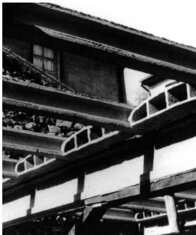
**Fig. 10. Vigas de concreto protendido usadas com os (naquela ocasião) novos blocos de concreto**
