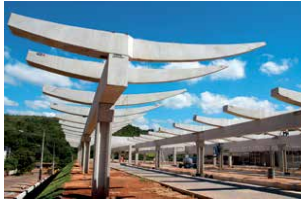
Figura 01 - Terminal Ibirité – Viga Barca (Assimétrica)
