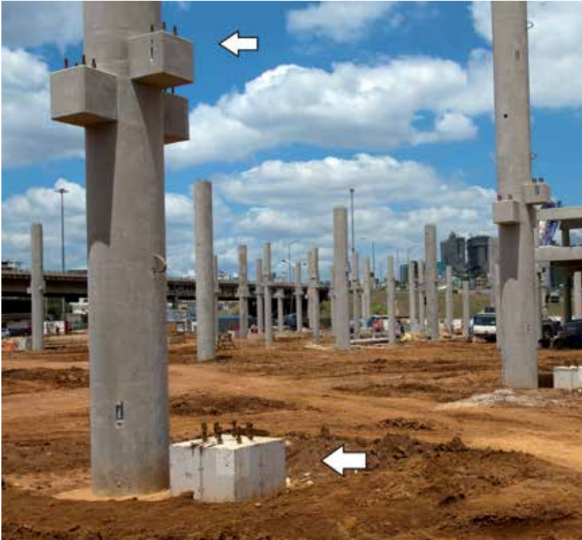
Figura 15: Blocos de fundação e consolos com inserts para interligação com estrutura metálica.
