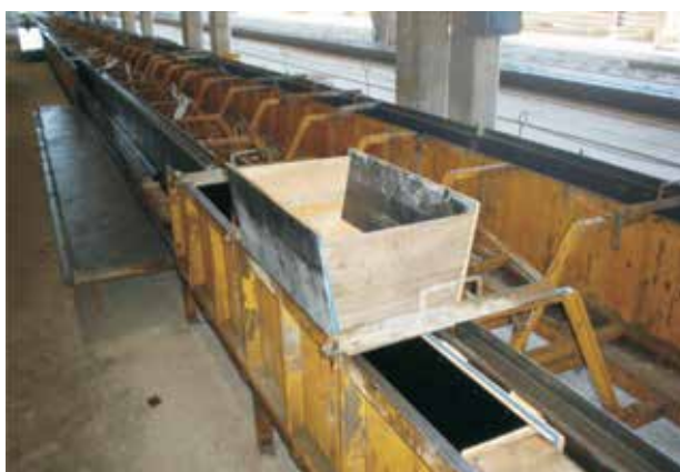
Figura 2. Funil de lançamento do concreto na fôrma de viga.
