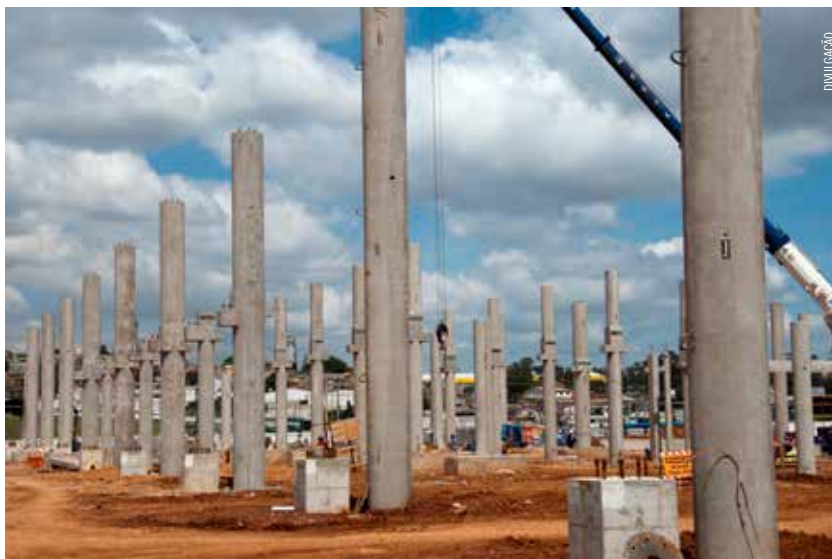
Montagem das vigas pré-fabricadas na construção do Terminal São Gabriel, em Belo Horizonte
