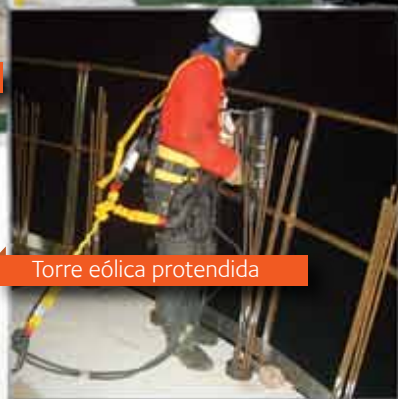
Torre eólica protendida
