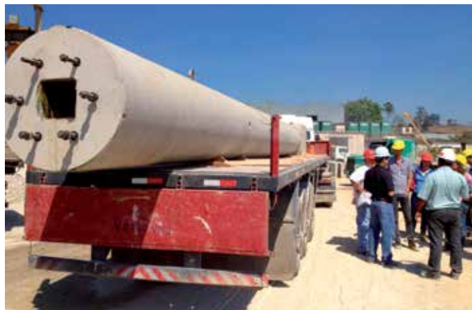
Figura 12: Pilar pré-fabricados de diâmetro 100 cm com inserts para interligação com estrutura metálica.
