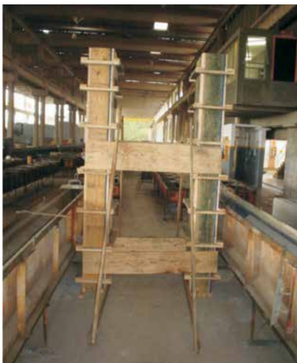
Figura 3. Fôrmas dos pilares.
