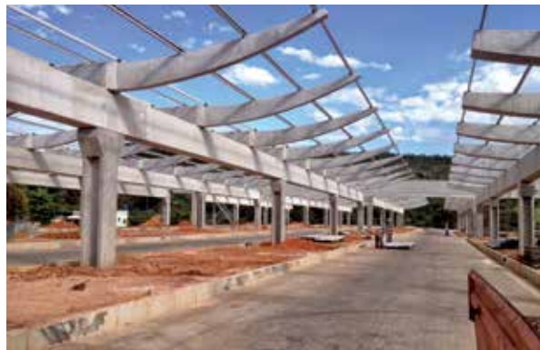
Figura 03: Vista inferior das vigas barcas (Assimétrica) com terças metálicas
