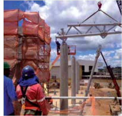
Figura 17: Montagem das interligações.
