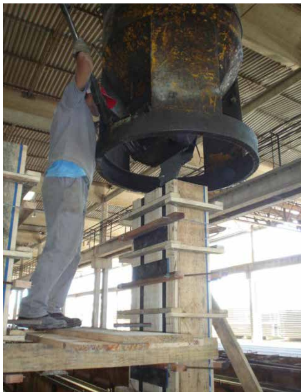
Figura 4. Lançamento do CAA em pilar.
