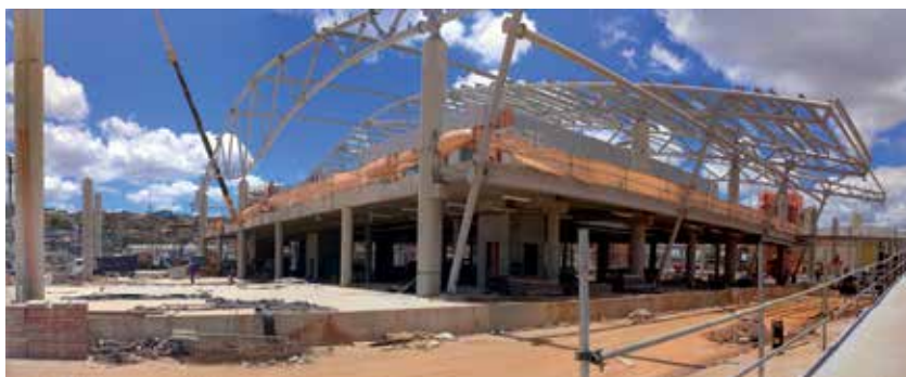
Figura 18: Montagem da cobertura
