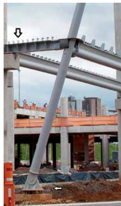
Figura 16: Interligação Pré-fabricado/Metálico conforme detalhe 6.
