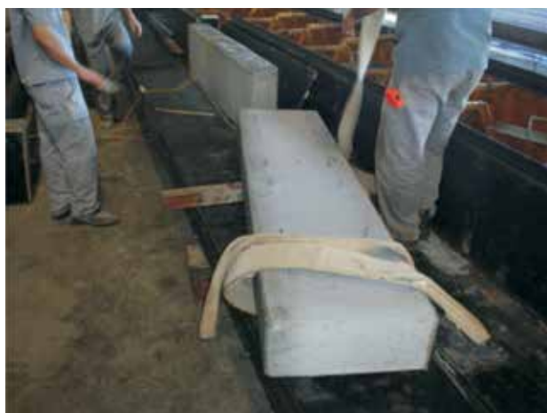
Figura 5. Desforma das vigas.
