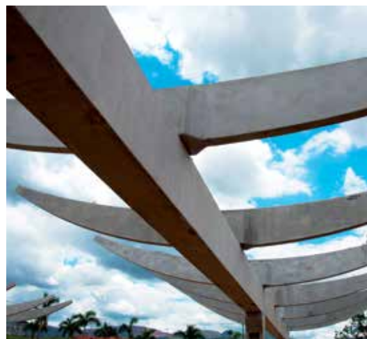
Figura 09: Vigas barcas apoiadas nas vigas calha
