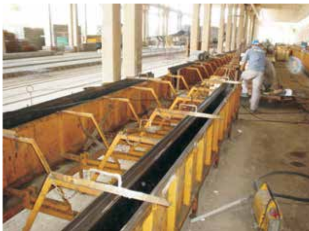
Figura 1. Fôrmas das vigas.
