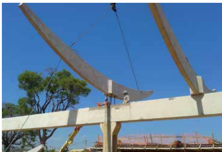
Figura 07: Solidarização da estrutura - Encontro das vigas calhas com pilar
