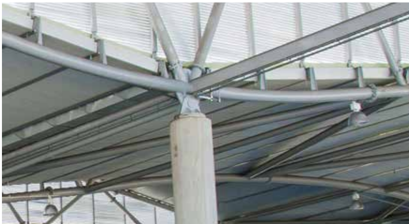
Figura 10: Vista da cobertura metálica e pilares pré-fabricados de diâmetro 100 cm
