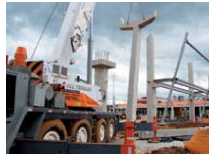
Figura 19: Montagem da passarela
