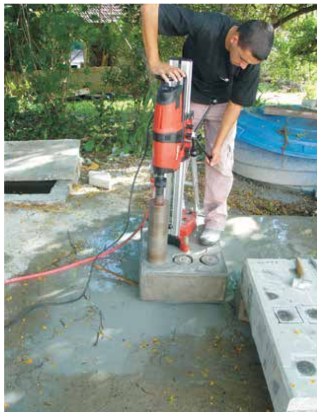
Figura 6. Extração de testemunhos de concreto.
