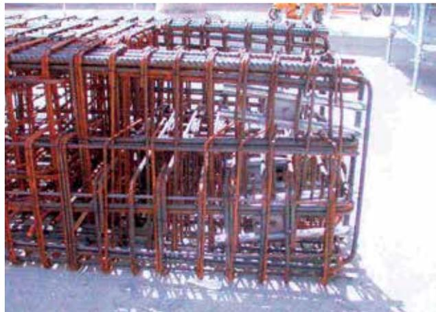
Figura 20. Armação na área da junta de dilatação
