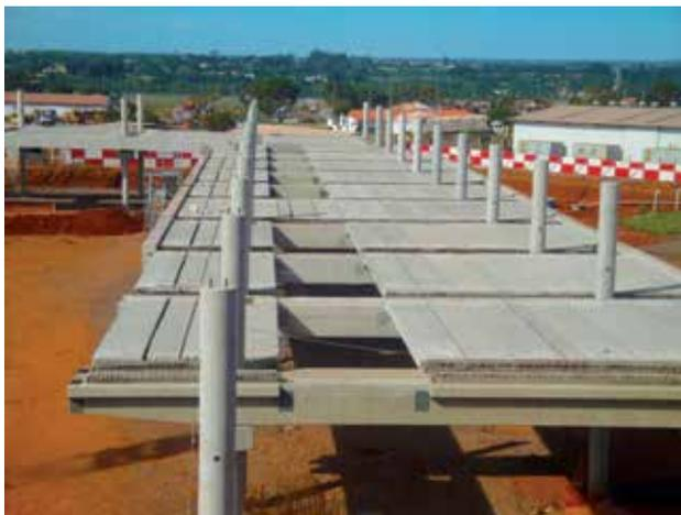
Figura 09 – esperas na estrutura para receber os perfis metálicos
