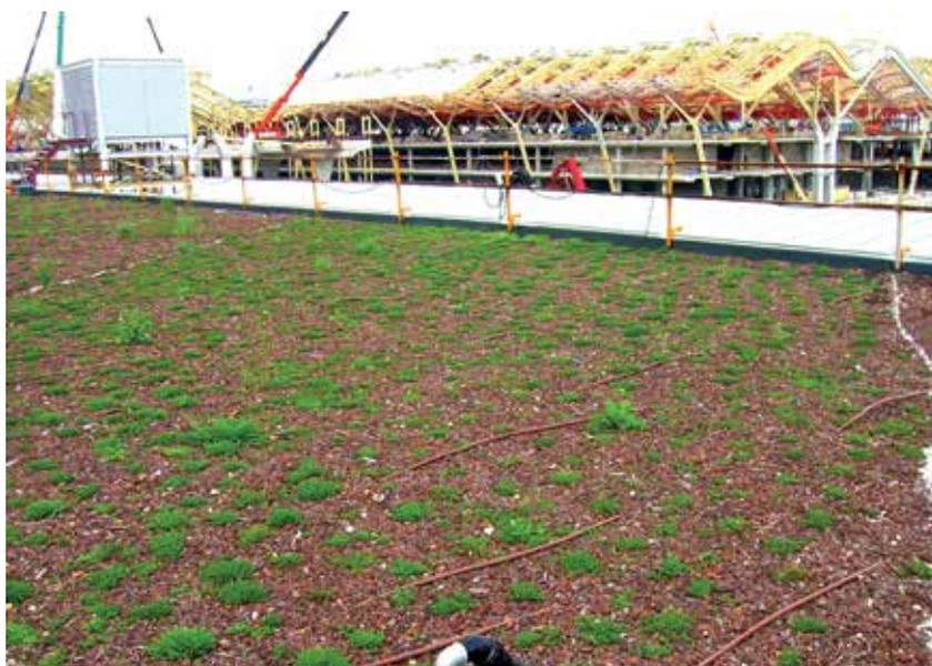
Figura 4. Aparência do telhado ecológico do estacionamento.
