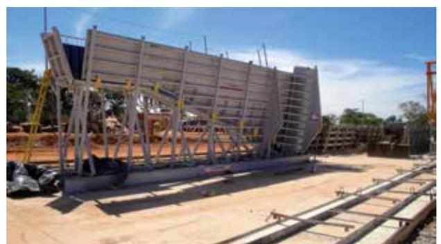
Figura 14 – Forma metálica dos pilares especiais
