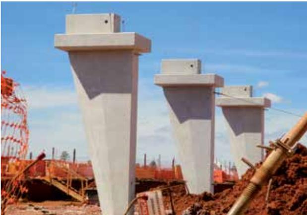
Figura 16 – Pilares utilizados na obra
