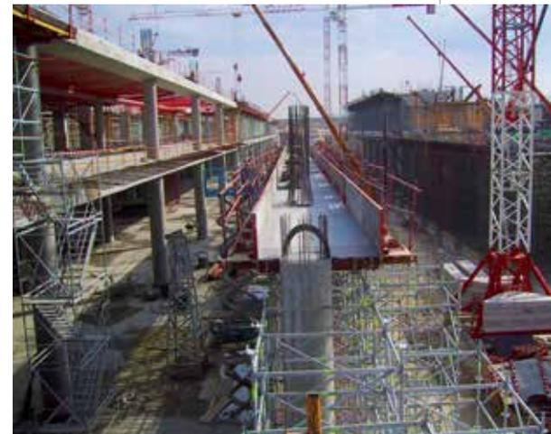
Figura 13. Armação dos pilares e compatibilidade com as bainhas dos tendões das vigas.
