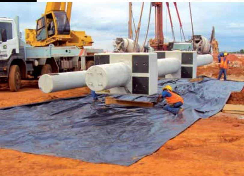
Figura 03-Pilares de periferia com seção multifacetada
