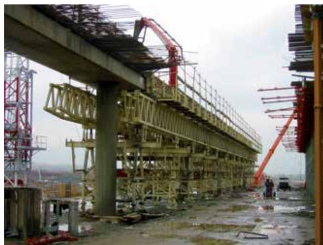
Figura 16. Processo de construção, concretagem da viga do pórtico com uma seção transversal compatível com o sistema de barras e construção posterior das lajes.
