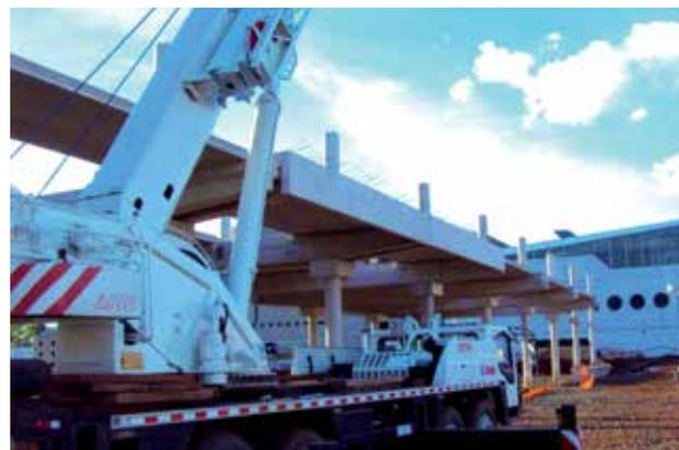
Figura 05- vigas já recebendo as testeiras de fachada
