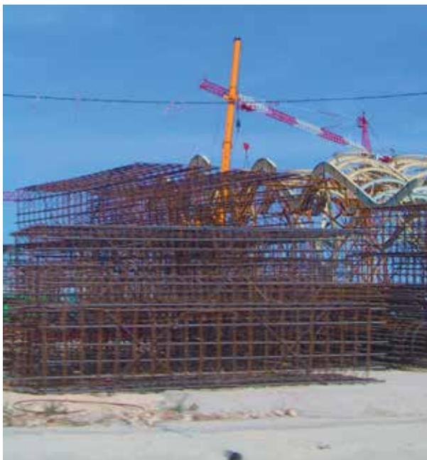
Figura 15. Processo de construção, montagem da armação ativa e passiva.
