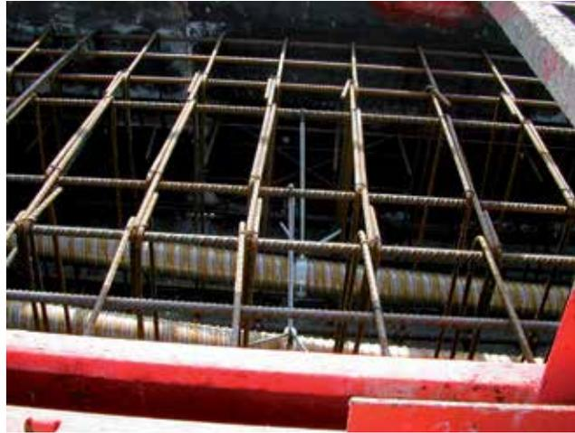
Figura 18. Enfileiramento e tensionamento dos cabos pré-tensionados.
