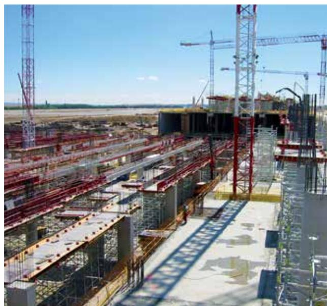
Figura 17. Processo de construção, descimbrado e movimento de cofragem autossustentável para uso posterior no próximo pórtico.
