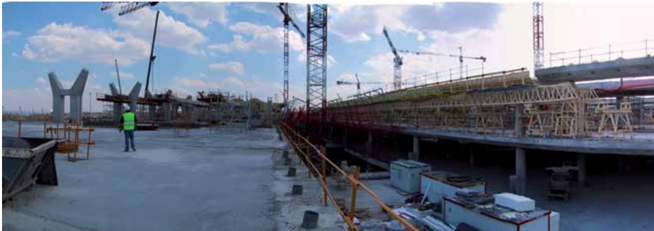
do que os pórticos estavam perfeitamente alinhados em grandes extensões. Este procedimento é muito comum na construção de pontes, mas não é normalmente usado na construção civil e permite a fabricação das vigas sem cimbrá-las. Este procedimento é combinado com o de suportes com formas tradicionais.
