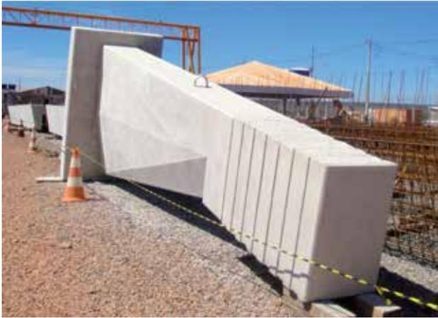
Figura 15- Pilar concretado
