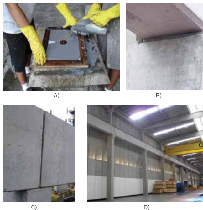
Fig. 2 Primeira aplicação das almofadas de argamassa modificada feita pela Marka Soluções Pré-fabricadas: a) moldagem das almofadas, b) vista inferior do apoio da viga de rolamento c) vista lateral do apoio das vigas de rolamento e d) vista geral da viga de rolamento.
