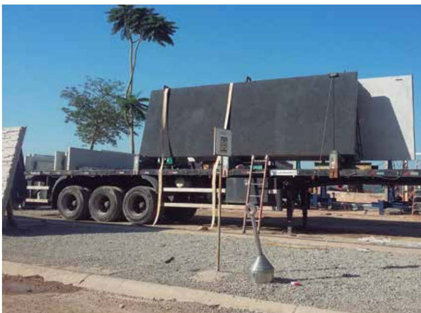
Painéis na fábrica prontos para a obra
