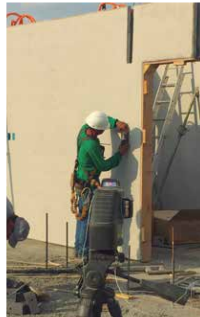
Painéis sendo montados na obra, pela Sudeste, já com o sistema de instalação de fábrica
