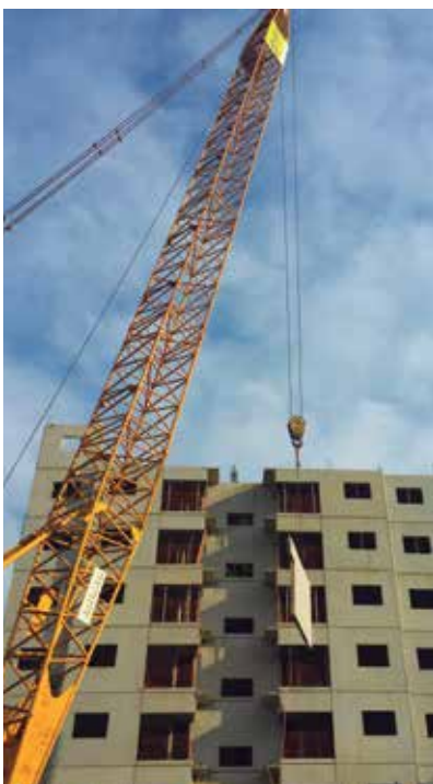
Montagem dos painéis
