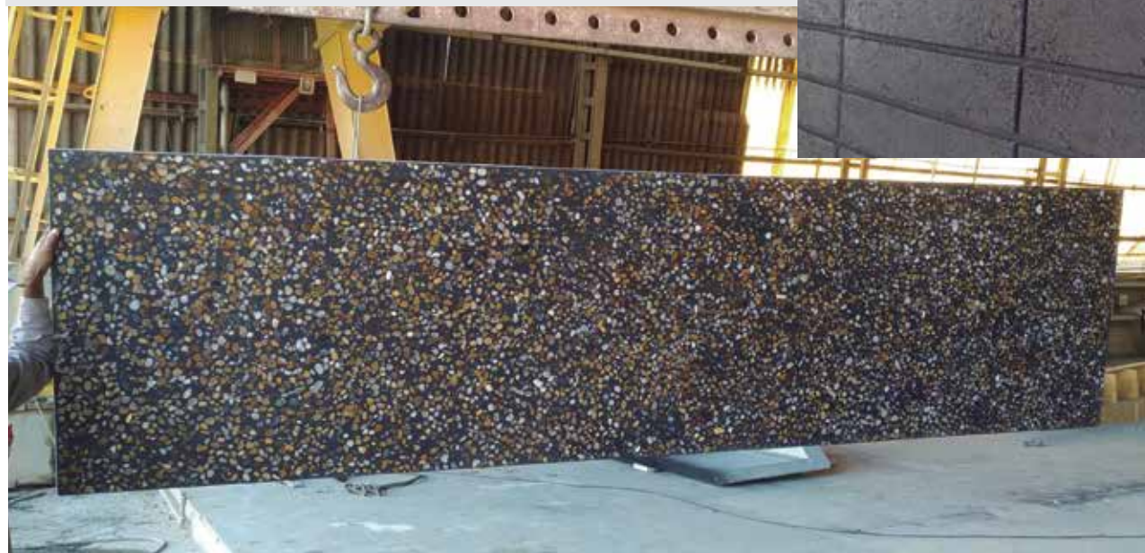
Painel polido com aplicação da resina na cor preta e painel tijolinho usados na obra
