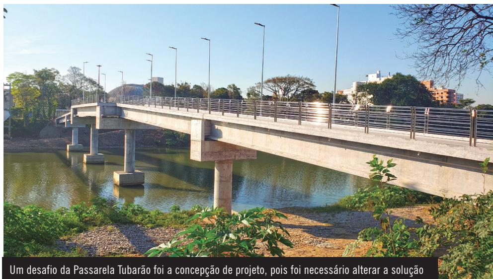
Um desafio da Passarela Tubarão foi a concepção de projeto, pois foi necessário alterar a solução das vigas do cliente de pós-tração para pré-tração, mas com a premissa de não alterar a arquitetura da obra
