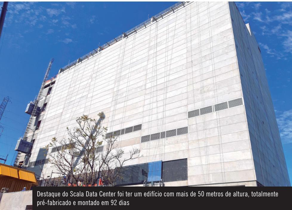
Destaque do Scala Data Center foi ter um edifício com mais de 50 metros de altura, totalmente pré-fabricado e montado em 92 dias
