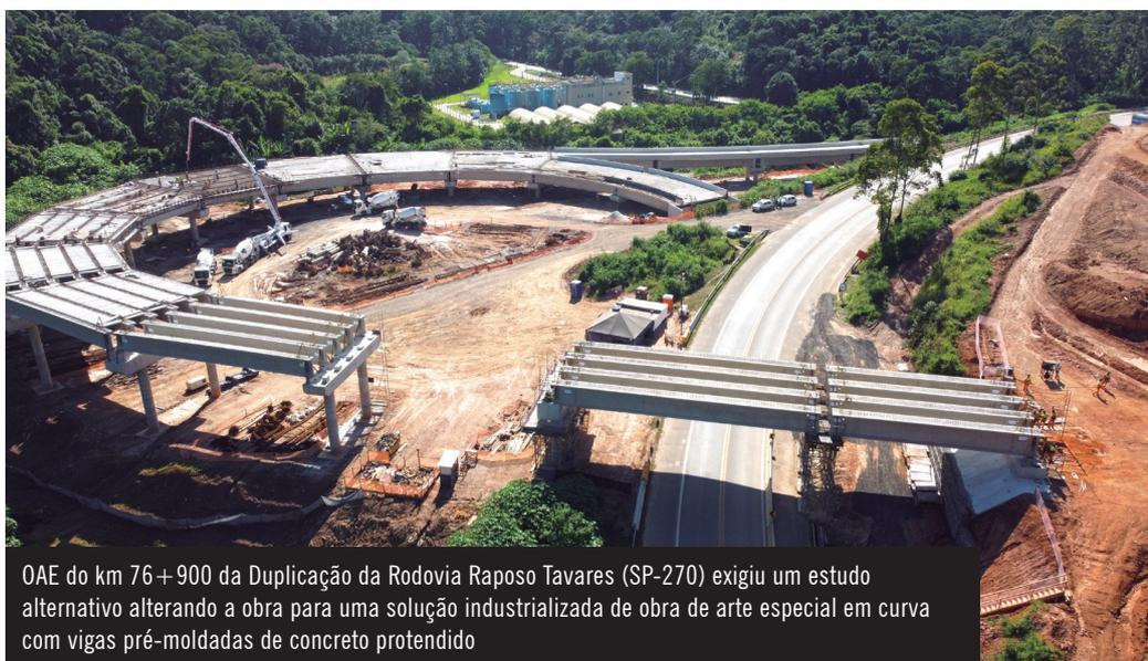
OAE do km 76+900 da Duplicação da Rodovia Raposo Tavares (SP-270) exigiu um estudo alternativo alterando a obra para uma solução industrializada de obra de arte especial em curva com vigas pré-moldadas de concreto protendido
