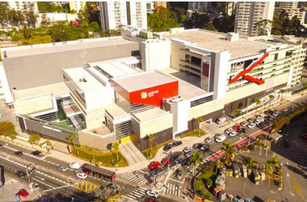
Shopping Morumbi Town teve uma sinergia determinante entre a construtora responsável pela obra, a área de projetos e a pré-fabricadora para propor a utilização de fcks de até 80 MPa.
