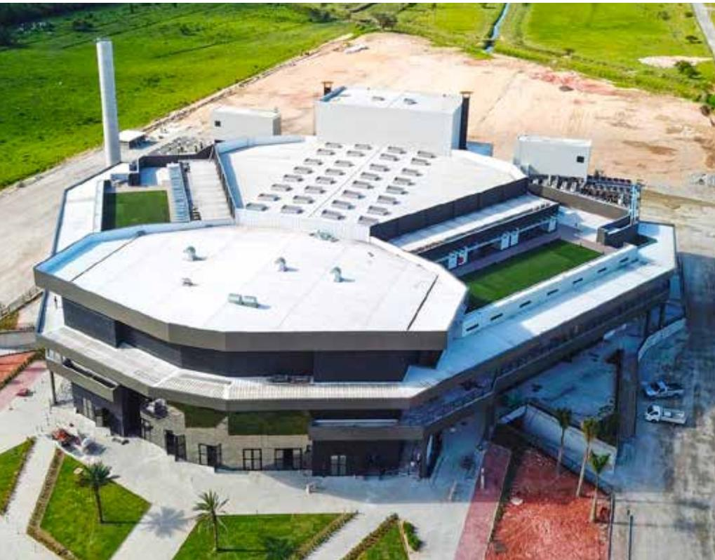
O pré-fabricado possibilitou a preservação da arquitetura da Arena Petry com todos seus detalhes e facilitou a compatibilização dos projetos através de modelagem em sistema BIM
