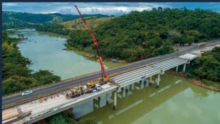
Construção com superestrutura pré-moldada de 01 Ponte sobre o rio Paranaíba no km 314 da BR-050, na divisa entre Minas Gerais e Goiás, com extensão de 200 m, fundações em estacas escavadas de até 20 m com perfuratriz Wirth, vigas longarinas protendidas pré-moldadas de comprimento 44,29 m montadas com treliça lançadeira e pré-lajes. Assim como a execução de 01 ponte sobre o córrego Maribondo no km 310 e 01 passagem superior no km 311.
