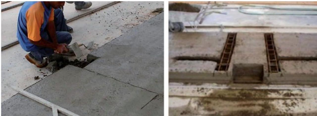
Figura 3: Execução de um recorte para pilar, com o concreto ainda fresco (foto à esq.); Reforço no recorte de pilar feito na pista (foto à dir.) [Fonte: Petrucelli (2009)]
