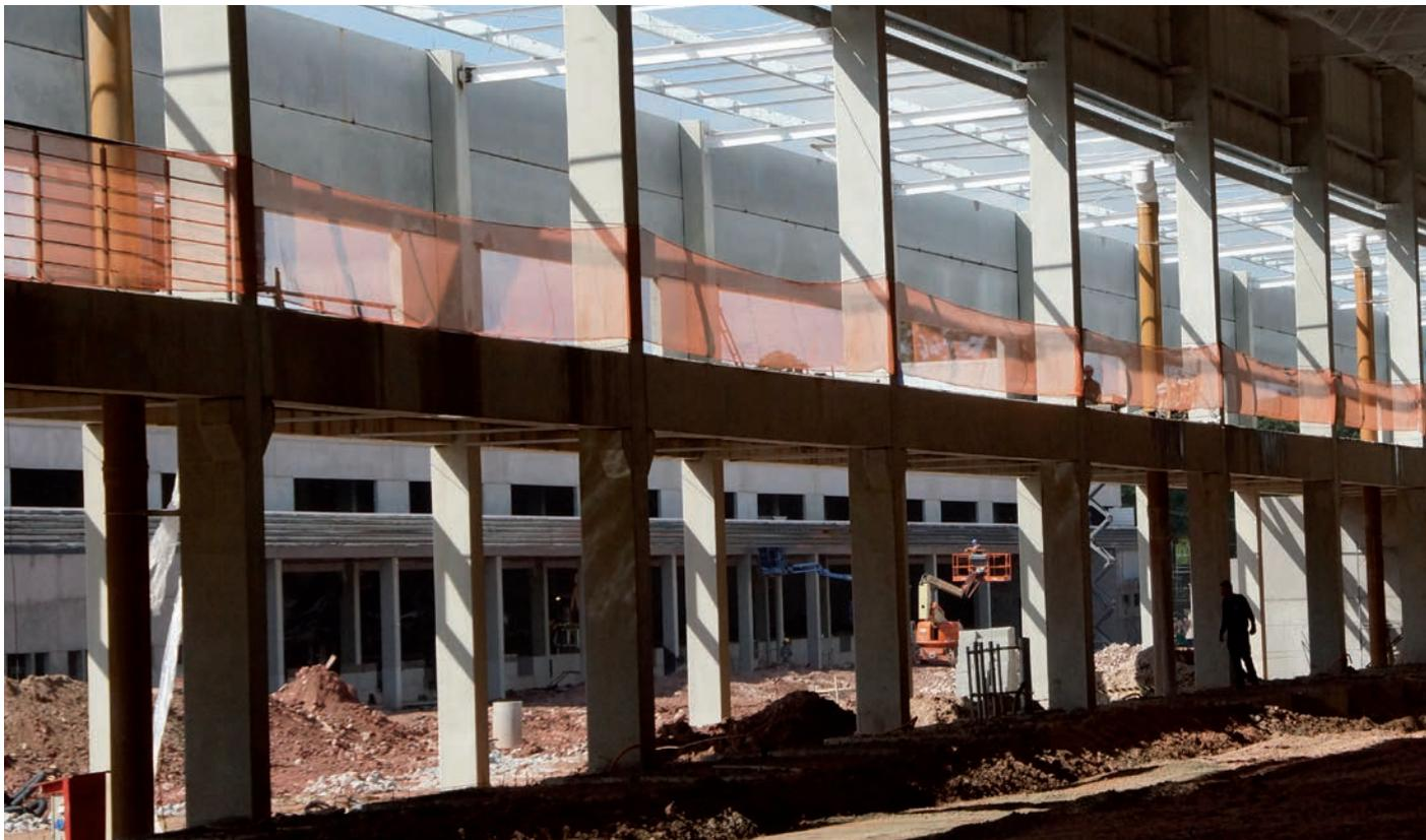
Pré-fabricado de concreto é mais vantajoso para construção de centros logísticos por acelerar a conclusão da obra
