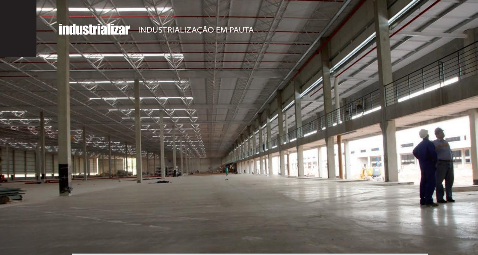
As estruturas pré-fabricadas de concreto são ideais para construção de centros de distribuição e logística por permitir grandes vãos
