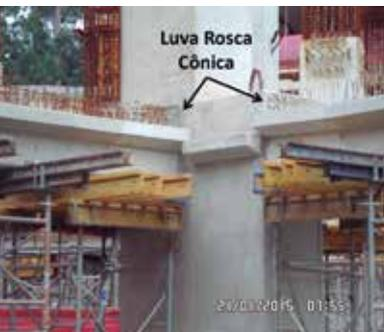
Figura 12. Imagem da aplicação da luva rosca cônica em um dos nós já consolidados após a concretagem.
