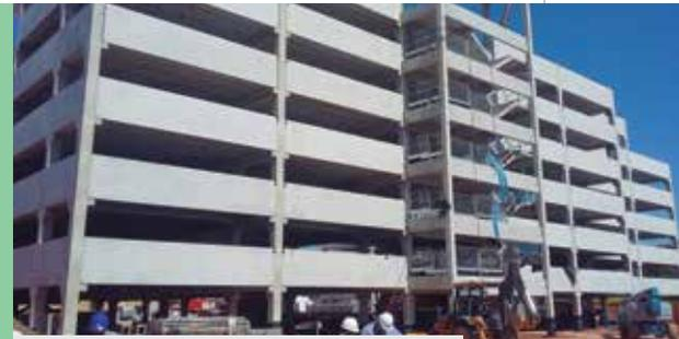
Atendimento do prazo para entrega da obra demandou três frentes de montagem do pré-fabricado, além do uso do BIM
