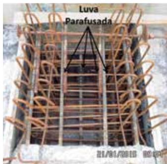
Figura 13. Detalhe de aplicação das luvas parafusadas na armação do nó entre uma das vigas pré-moldadas.
