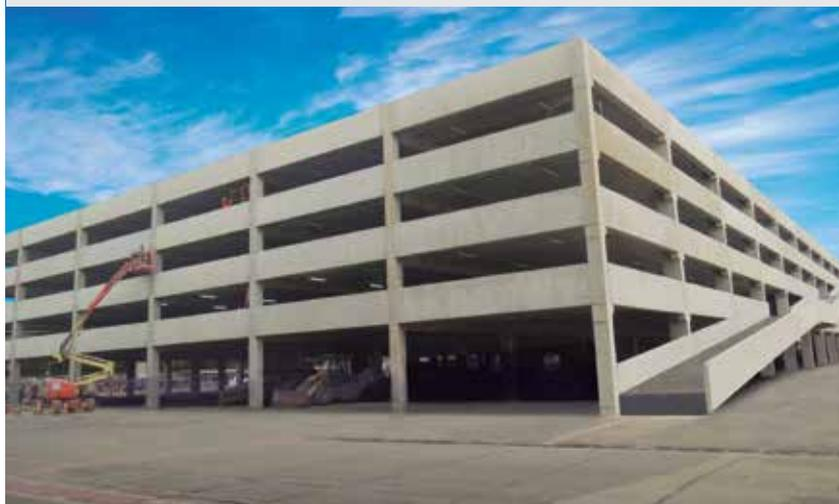
ca do pilar e do balanço, que foi executada mediante o desenvolvimento de um traço específico do concreto. Foi dada também atenção especial na hora de retirar o pilar da forma, uma vez que seu peso total chegava a quase 20 toneladas.
