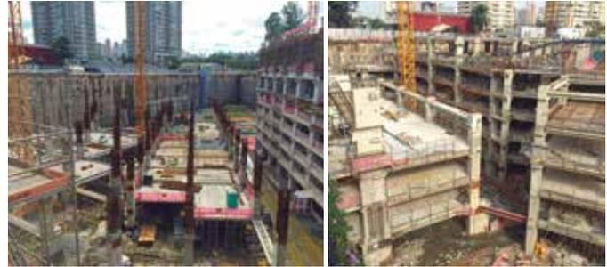
Figura 14. Primeira etapa da instalação dos pilares pré-fabricados (Fevereiro/2015).
