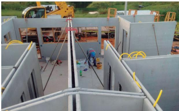
Figura 1 – a) Sistema com painel maciço (esquerda); b) Sistema com parede dupla (direita)
