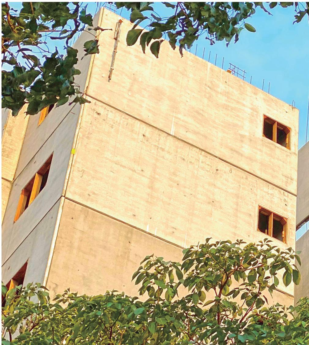
um ambiente industrial para serem montados posteriormente no canteiro de obras. A fabricação pode ser de estruturas únicas com a utilização de ligações para união dos elementos até unidades volumétricas 3D com acessórios completos.
