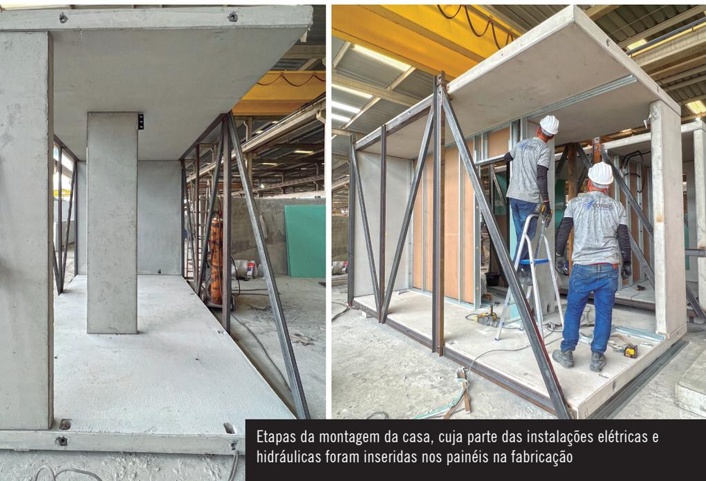
Etapas da montagem da casa, cuja parte das instalações elétricas e hidráulicas foram inseridas nos painéis na fabricação
