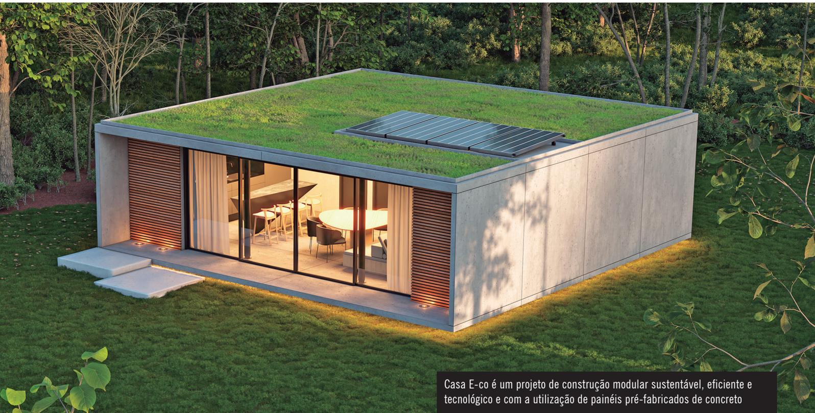
Casa E-co é um projeto de construção modular sustentável, eficiente e tecnológico e com a utilização de painéis pré-fabricados de concreto
