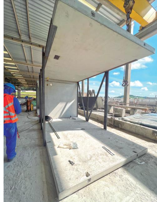
Início da montagem da casa, que possui oito módulos, formados pela união de painéis pré-fabricados de concreto unidos entre si e formando em síntese elementos 3D com formato em C.
