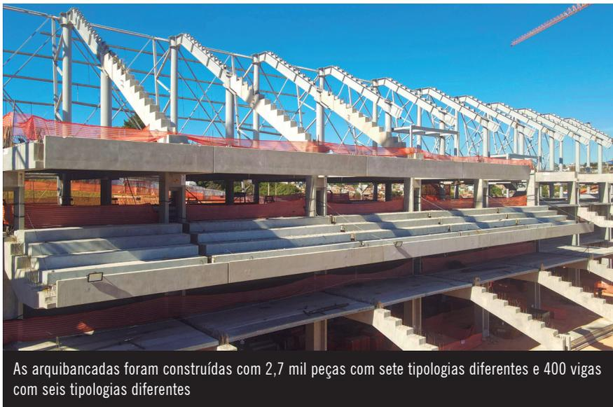
As arquibancadas foram construídas com 2,7 mil peças com sete tipologias diferentes e 400 vigas com seis tipologias diferentes
