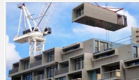
Tecnologia Prefabricated Prefinished Volumetric Construction (PPVC) (Construção Volumétrica Pré-fabricada) utiliza módulos que se encaixam.
