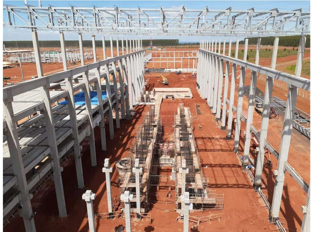
Solução com alto índice de padronização de peças, para obter mínimo tempo de fabricação e montagem
