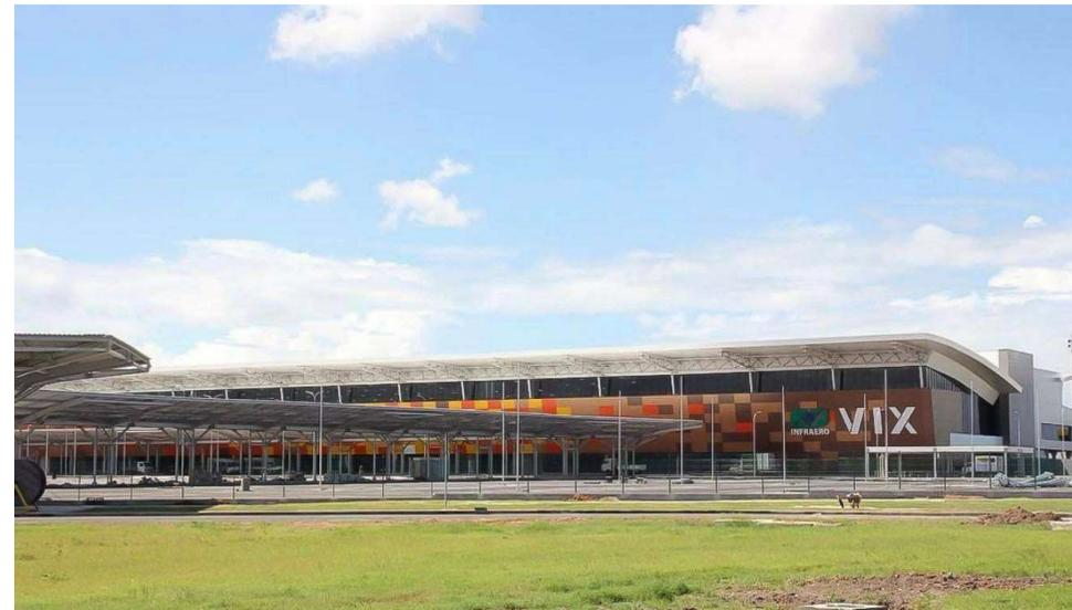
16.000m<sup>2</sup>, 6.210m<sup>3</sup>, pilares em “V”, com 20m de altura e vigas de até 22,5m
