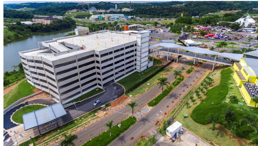
22.500m<sup>2</sup>, 6 pavimentos, estacionamento para 2000 veículos, montagem em 90 dias
