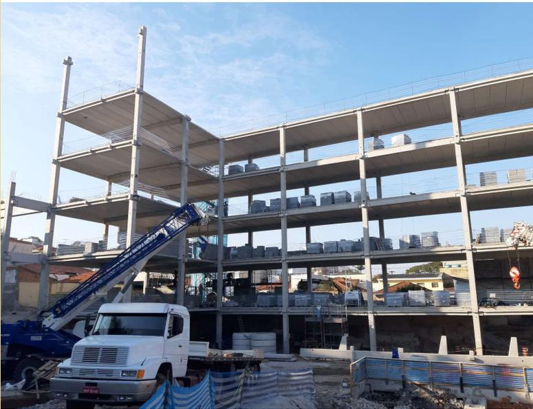
Obra dentro de zoneamento restritivo da capital – SP. Grande controle logístico (inexistência de espaço para estocagem) e alta velocidade de execução
