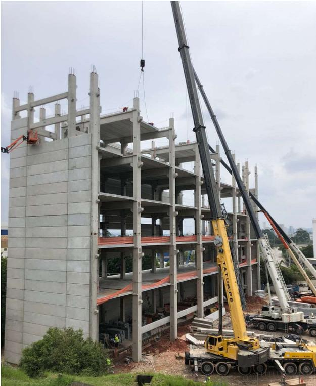
Concreto de Alto Desempenho, modularização, precisão dimensional do pavimento (F Number), com sobrecarga de 3,5 ton/m<sup>2</sup>
