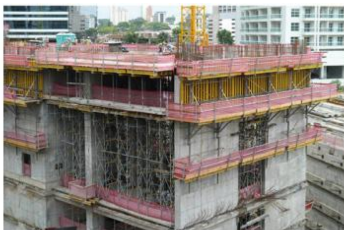
Figura 14 | Construção da Torre C2
