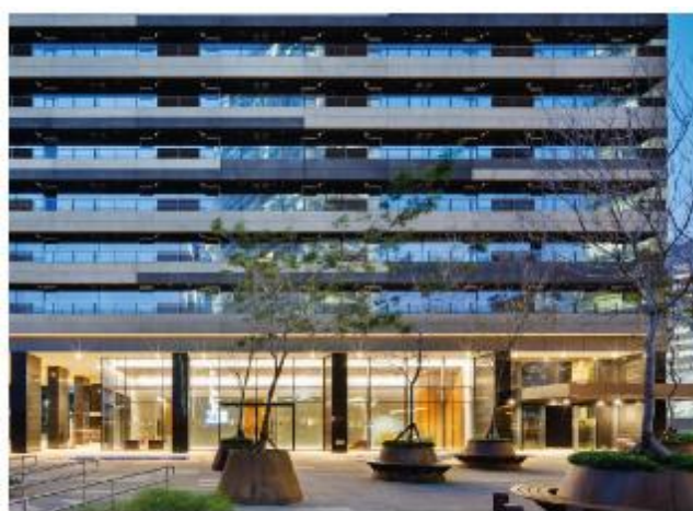
Figura 15 | Torre C2 finalizada
