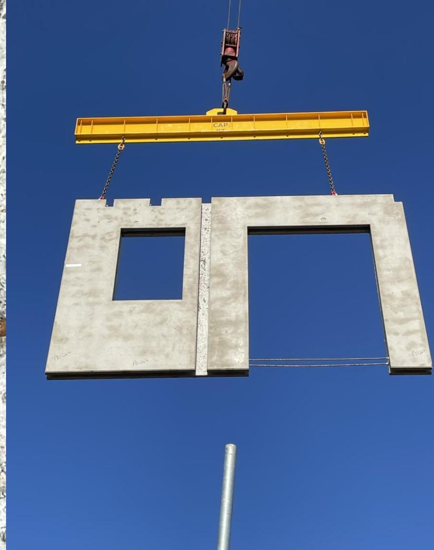
**Montagem painéis duplos e painéis maciços com detalhes especiais de ligações para estabilidade em prédio de 15 pavimentos.**
