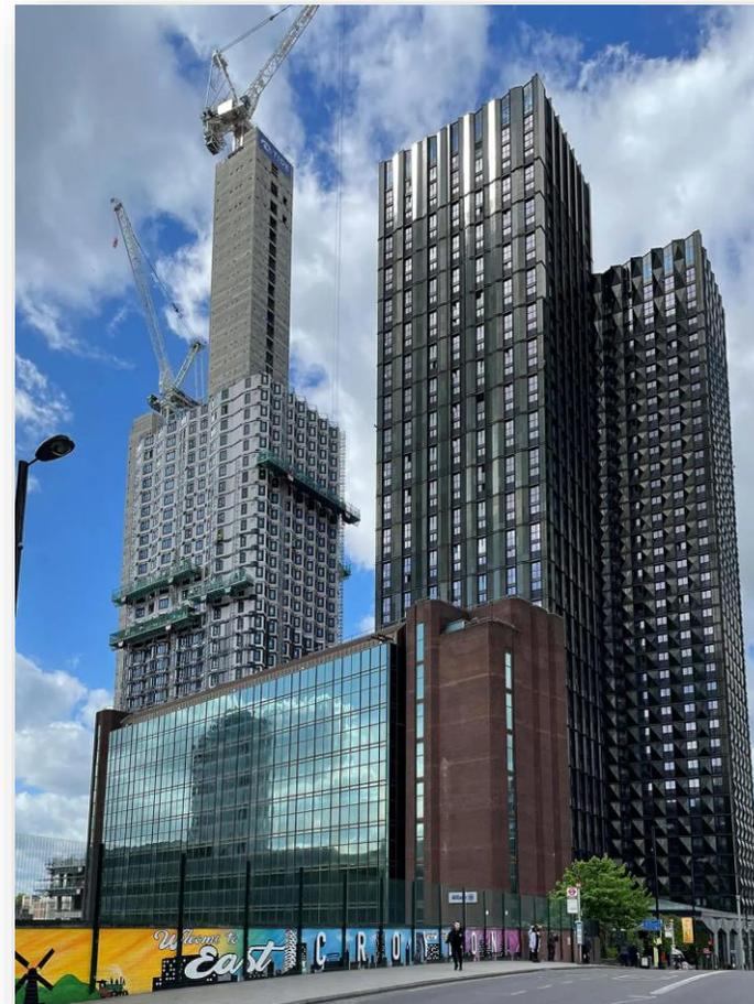
O 101 George Street é alto em Londres e atualmente é o edifício modular volumétrico mais alto do mundo, construído pela Vision Modular Systems (VMS). O College Road, outro edifício modular, está sendo construído logo atrás, com 136 metros de altura.
