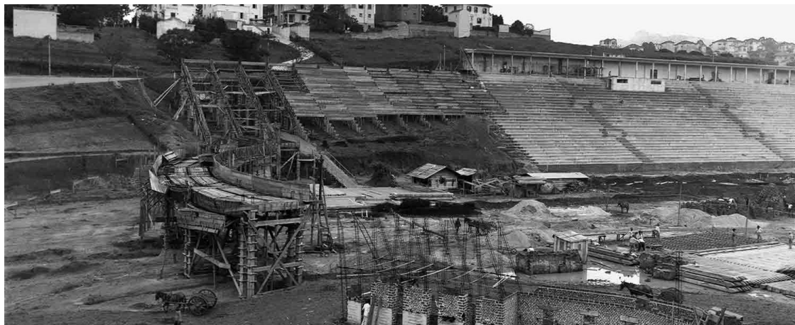
Execução das arquibancadas sobre o talude natural do terreno em 1940
