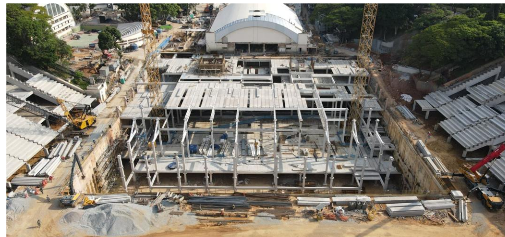
Montagem do EDM dentro da parede diafragma
