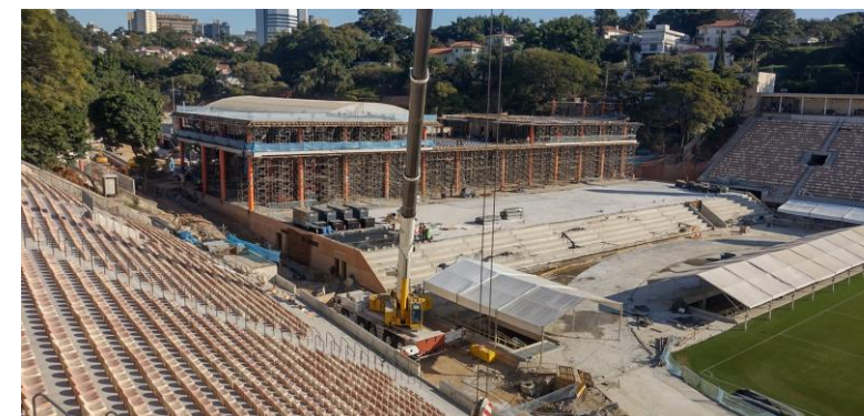
EDM avançando a estrutura in loco
