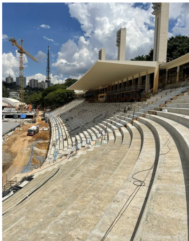
Encontro da arquibancada original com a nova estrutura pré-fabricada
