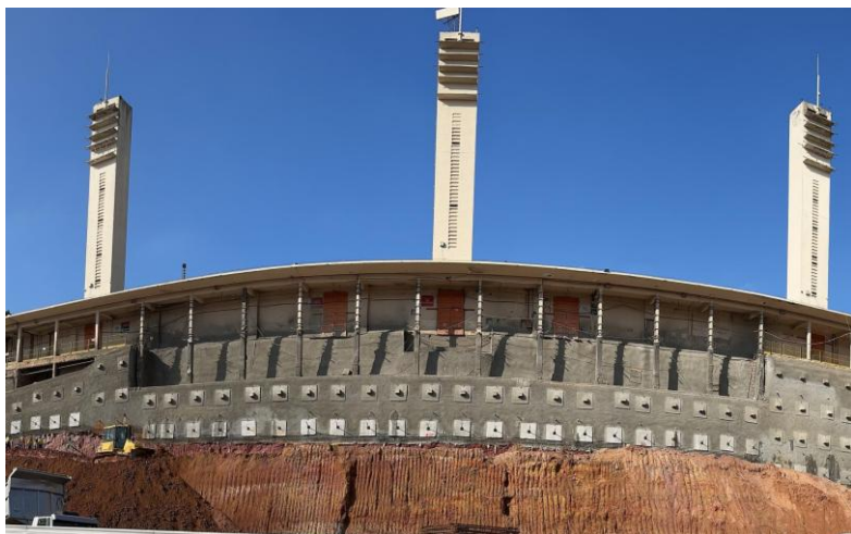
Arquibancada leste em execução da cortina e reforços da estrutura
