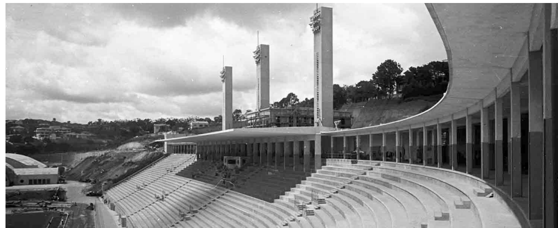
Vista parcial da arquibancada, com a curvatura contínua acompanhando a encosta
