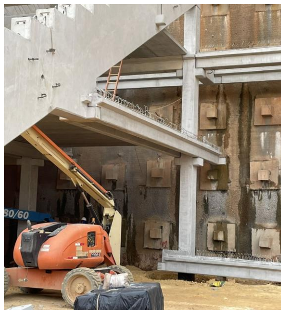
Vigas duplas para recebimento de lajes
