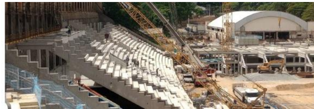
Montagem da arquibancada leste, concreto exposto às intempéries
