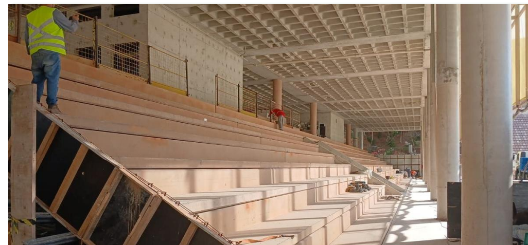
Montagem do EDM – bancos pigmentados internos (montagem posterior)
