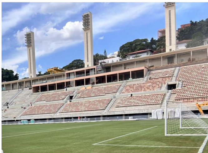
Arquibancada leste finalizada
