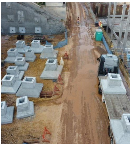
Sapatas pré-fabricadas entregues para as fundações da arquibancada
