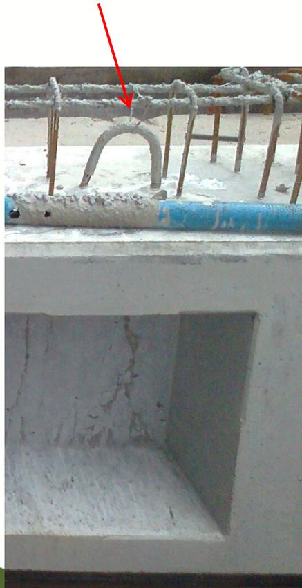
Alça produzida com Cabo de aço ( alma flexível) + armaduras.
